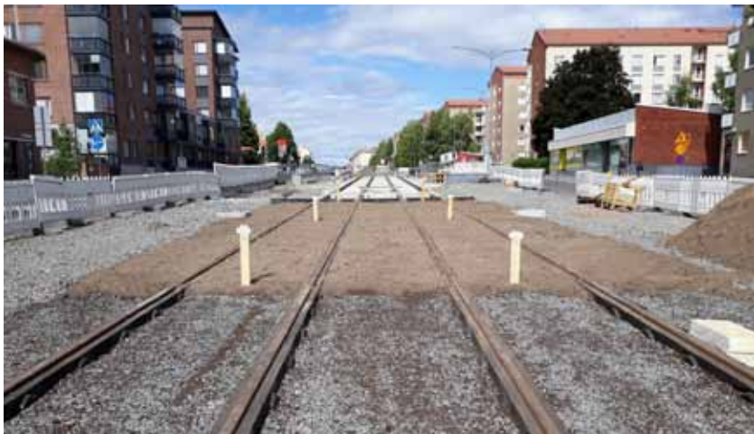
Koerakenteissa testataan mm. erilaisia mikrokantavia kasvualustoja. Jokaisen koealan päällä on 10 cm kerros samaa nurmikon tuotteistettua kasvualustaa. Kuva: Teemu Niemi
