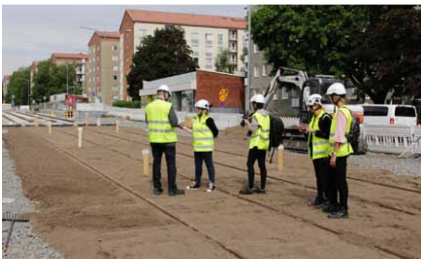
Koerakenteiden rakentaminen kiinnosti median edustajia. Medialle pidettiin oma esittelypäivä koerakenteiden kylvövaiheessa. Kuva: Marja Merta
