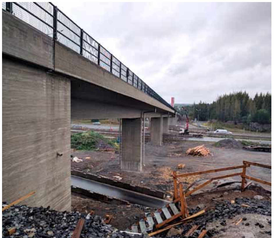
Valtatie 9:n ylittävät S14 ja S15 Vackerin alikulkusillat valettiin kesällä 2018. Antti Kivi- niemi / Raitiotieallianssi.
