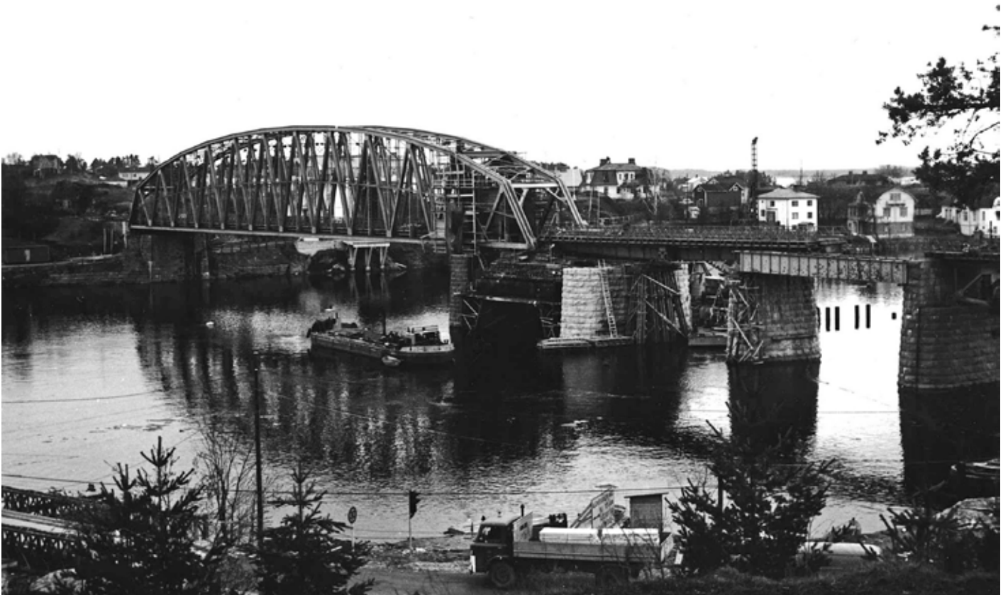
Kuva 5. Ristikkosillan lyhentäminen käynnissä vuonna 1968.
