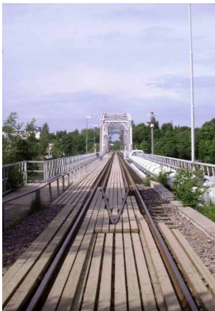
Kuva 3. Sillalla on edelleen kansilankutus hälytysajoneuvoille.
