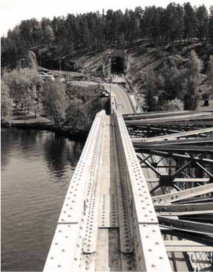
Kuva 4. Sillan huipulta näkyvissä itään päin tieyhteys ja valmistuva tunneli.
