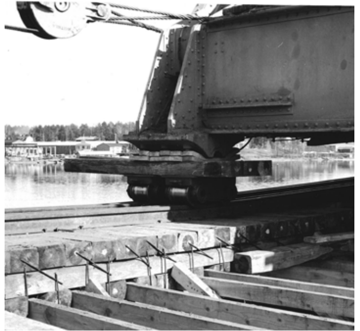
Kuva 6. Siltajänteen siirto käynnissä.
