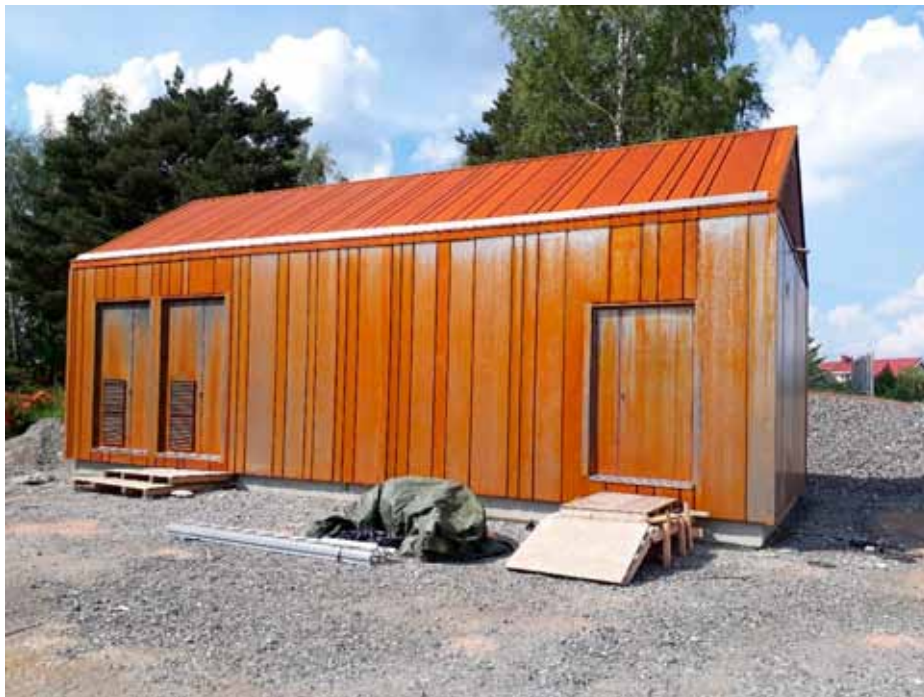
Ensimmäinen raitiotien sähkönsyöttö- asema valmiina. Mikko Nyhä / Raitiotie- allianssi.
