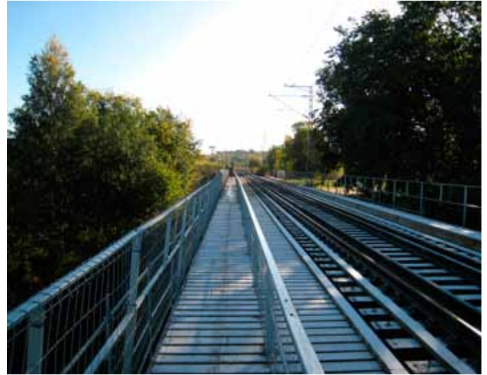
Kuva 3. Jalankulku-uloke raiteen vieressä.
