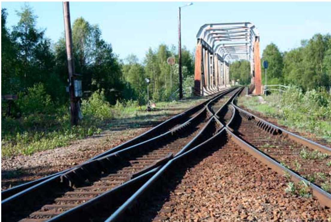
Yhdistettyjä 1524 ja 1435 mm raiteita Torniossa. Kuva Markku Nummelin.
