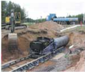
Työntöporasta American Augers 72-1200NG koneella, DN1600 asennus.
