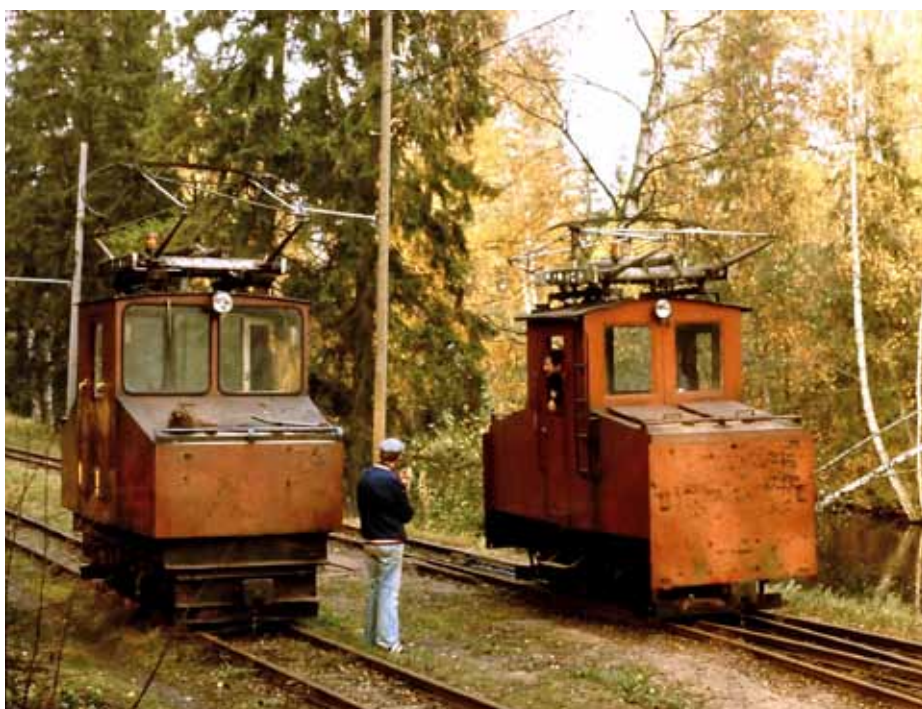
Turvesuolla aikanaan käytetty Schienen-Kuli-veturi. Raideleveys on 600 mm. Kuva Kalle Renfeldt.
