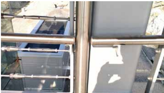
Kuva 3 Kaiteiden jatkuvuutta ei saa katkaista kuivatusrakenteella
