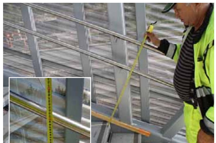
Kuva 1. Kaide-etäisyys rakentamismääräyskokoelman mukaan mitattuna
