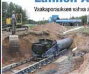
Työntöporaus American Augers 72-1200NG koneella, DN1600 asennus.
