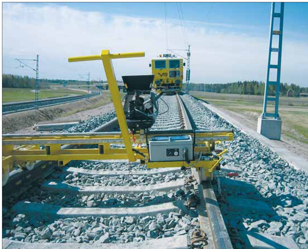
Kone työskentelee Kerava-Lahti oikoradalla kaarrelaserin ohjaamana.
