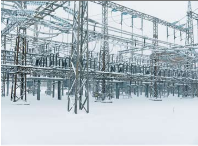
Urakan lopulla purettava 110 kV avokytkinlaitos. (Kuva: Tomi Ovaska, VR Track)
