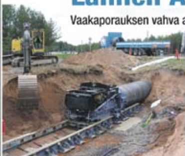
Työntöporaus American Augers 72-1200NG koneella, DN1600 asennus.
