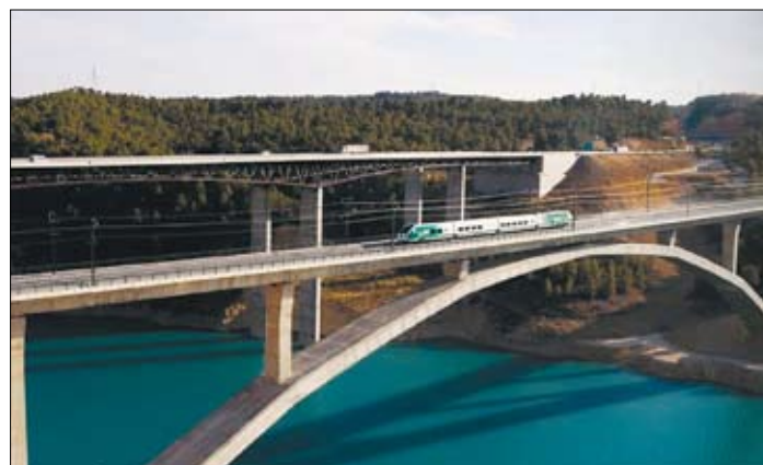
Espanjan suurnopeusradoilla on merkittäviä siltoja. Kuvassa Madrid - Valencia radalta 587 m pitkä vesivaraston ylittävä viaduktisilta, jossa on Euroopan pisin ratasillan kaari 261 m.
