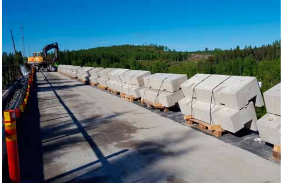
Kuva 11. Uusia reunapalkkielementtejä jaettuna kannelle.
