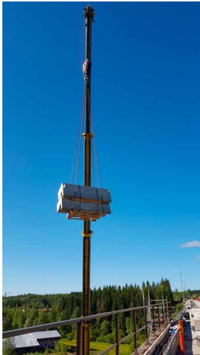
Kuva 10. Reunapalkkielementit jouduttiin nostamaan korkealle sillalle.
