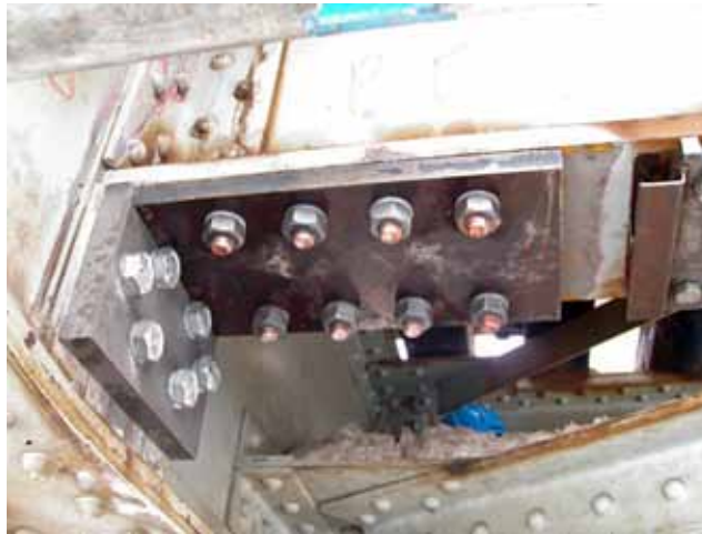
Kuva 2: Niittiliitoksen vahvistuslevy vanhassa Temmesjoen ratasillassa.
