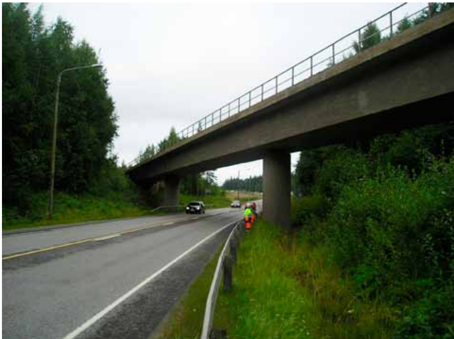
Kuva 3: Vanha Vihtiälän alikulkusilta uusittiin Jyväskylä-Äänekoski hankkeessa.
