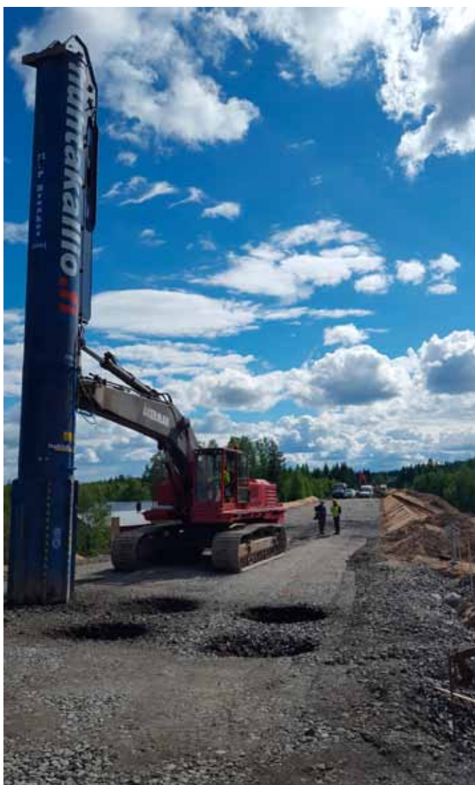
Kuva 1. Penkereen korjaus käynnissä.
