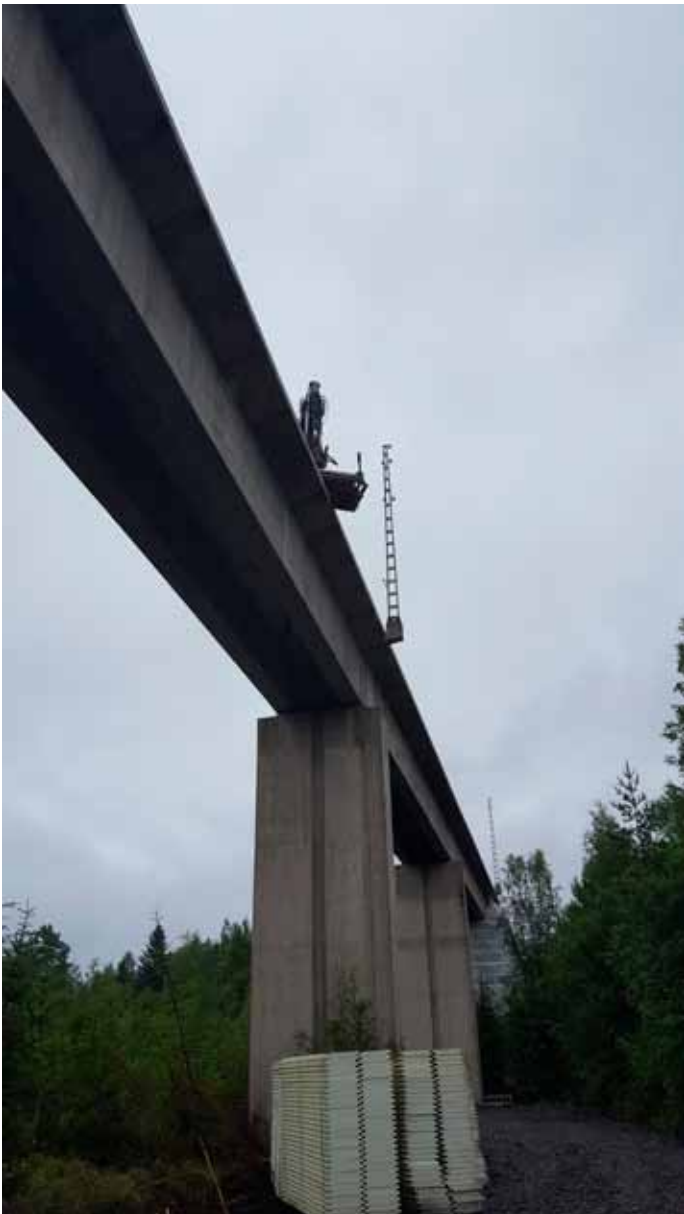
Kuva 12. Kannen harjaus käynnissä sillalla.
