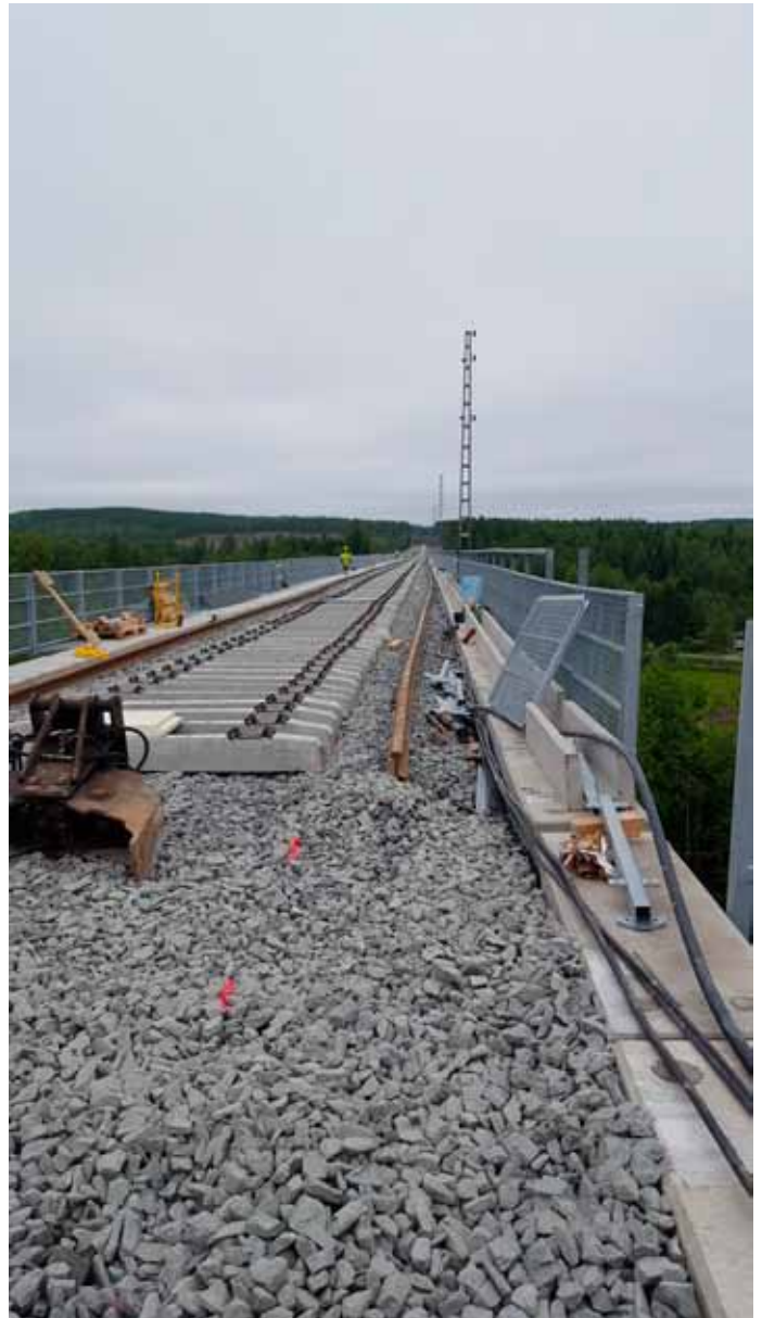
Kuva 14. Raiteen palautusta alikulkusillalla.
