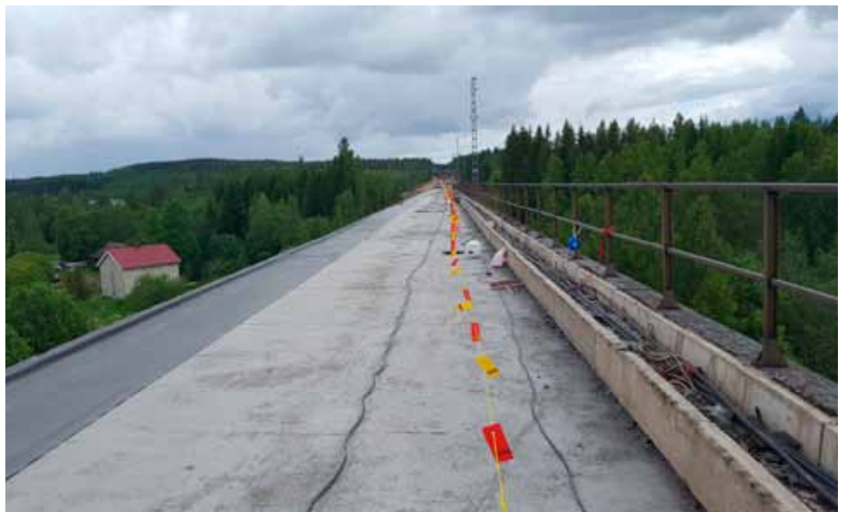
Kuva 8. Vasemman puolen reunapalkkielementtien alustan eristystä levitettynä. Eristys tehtiin kaistoittain. Ensin oikean ja vasemman puolen reunat ja viimeisenä kannen keskialueen eristys. Keskikaista säilytettiin kulkuväylänä mahdollisimman pitkään.
