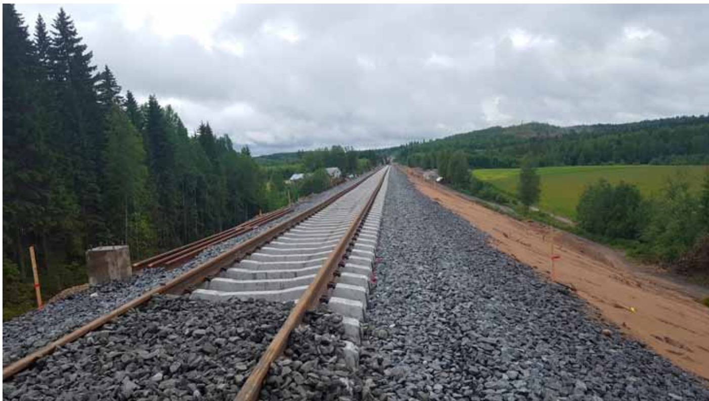
Kuva 13. Lähes valmista rataa penkereellä.
