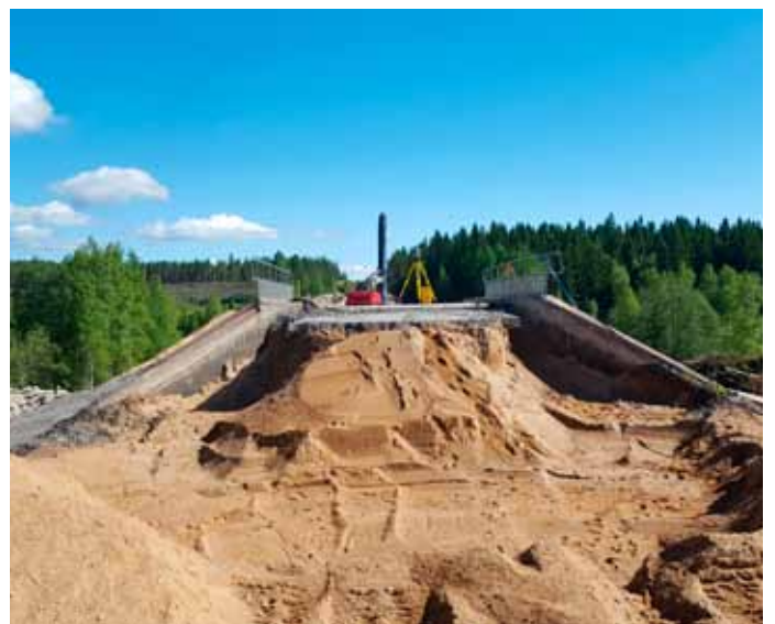
Kuva 5. Mäntylän alikulkusillan kohdalla purettua ratapengertä.
