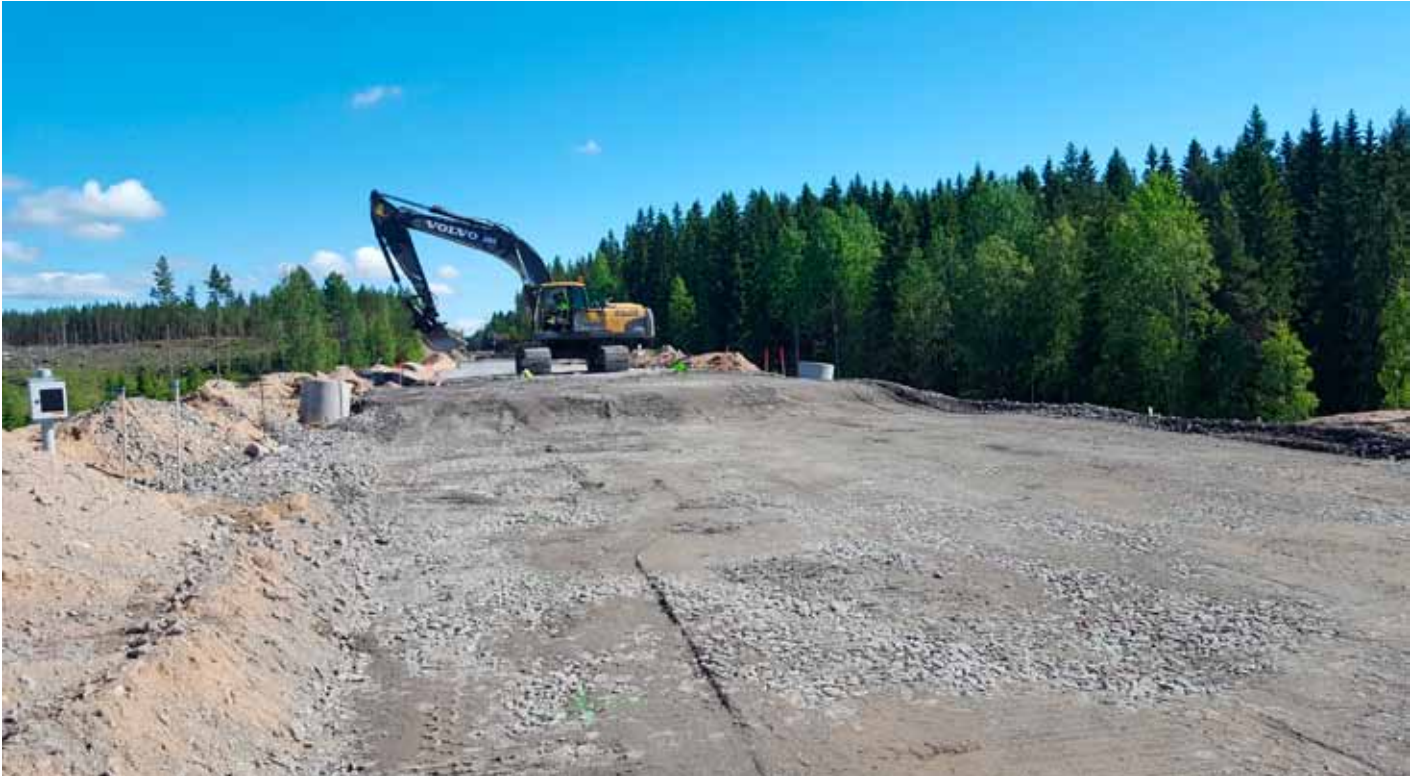
Kuva 2. Kaivinkoneesta kuvan etualan suuntaan pudotusalusta tasattuna pudotustiivistystyksen jälkeen, aluepainuma n. 0,5 m.
