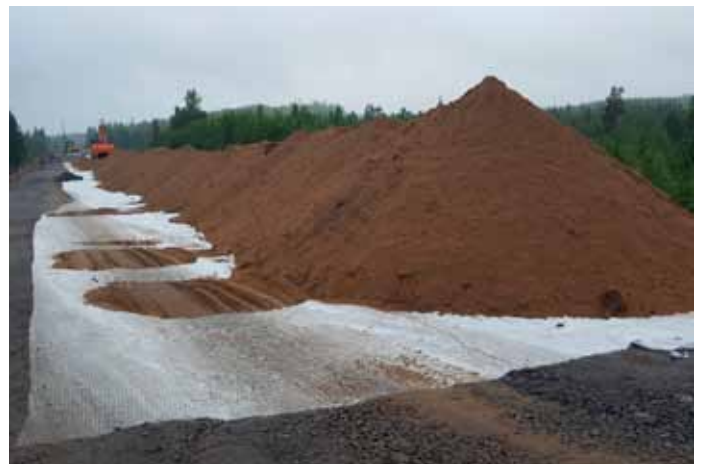
Kuva 3. Ratapenkereen eristyskerroksen palautusta ja lujiteverkkoa.
