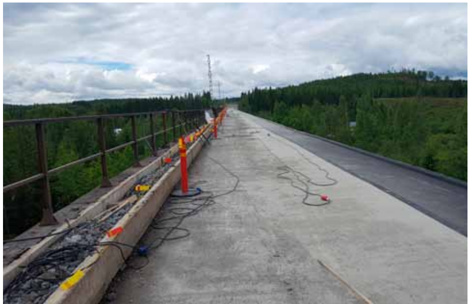
Kuva 7. Suojabetoni paljastettuna ja toisen puolen kaide irrotettuna.
