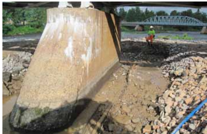
Kuva 2. Välituen korjausta varten 2011 tuen ympärys padottiin toimenpidettä varten. Taustalla näkyy vanha rautatiesilta, joka nykyisin maantiekäytössä.
