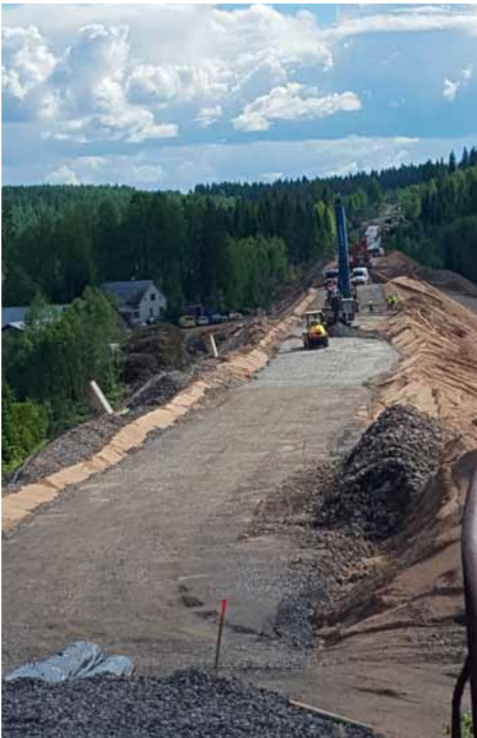
Kuva 4. Ratapengertyömaan yleisnäkymää Jämsän suuntaan.
