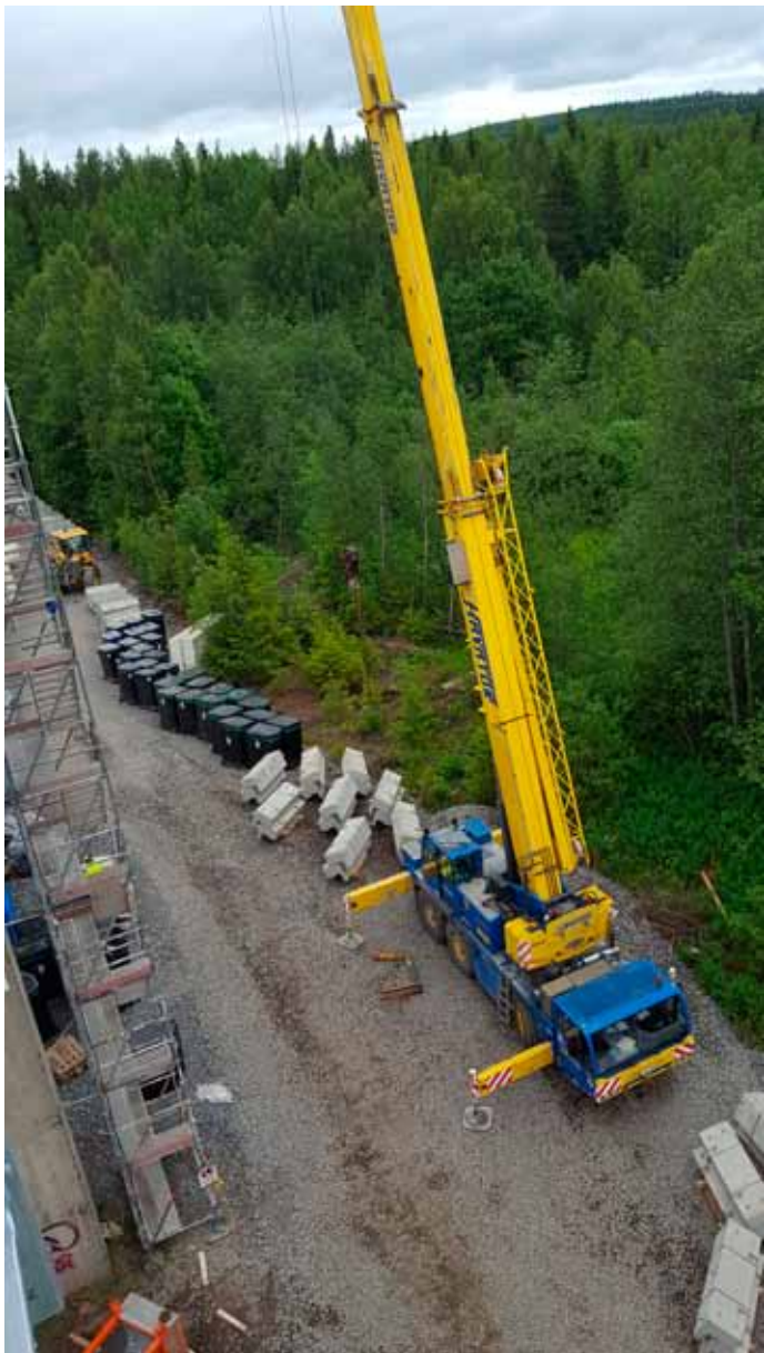
Kuva 9. Reunapalkkielementtien nostoa autonosturilla sillan keskikohdalla, josta jako pyöräkoneella kantta pitkin molempiin suuntiin.
