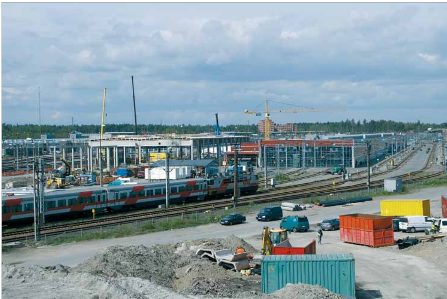
Helsingin varikolla on käynnissä suuri perusparannustyö
