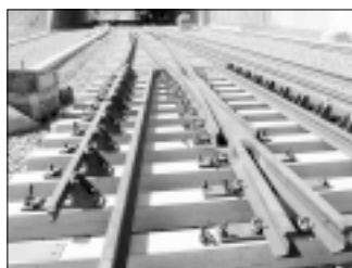
Pandroll-kiinnitteinen betonipölkyvaihde.
