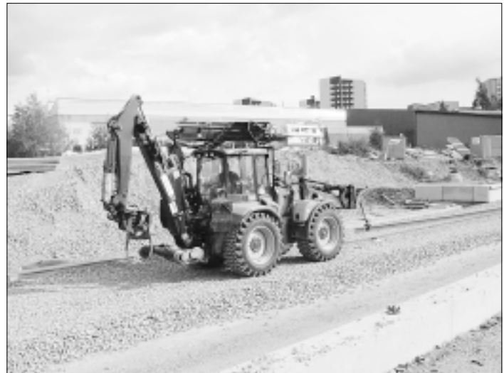
Huddig siirtää 420 metriä kiskoa rullien päällä.
