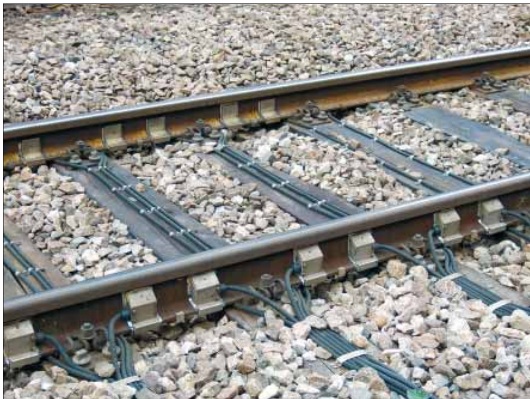
Kuva 1. Kiskoon asennettu venymäantureita, SBB.
