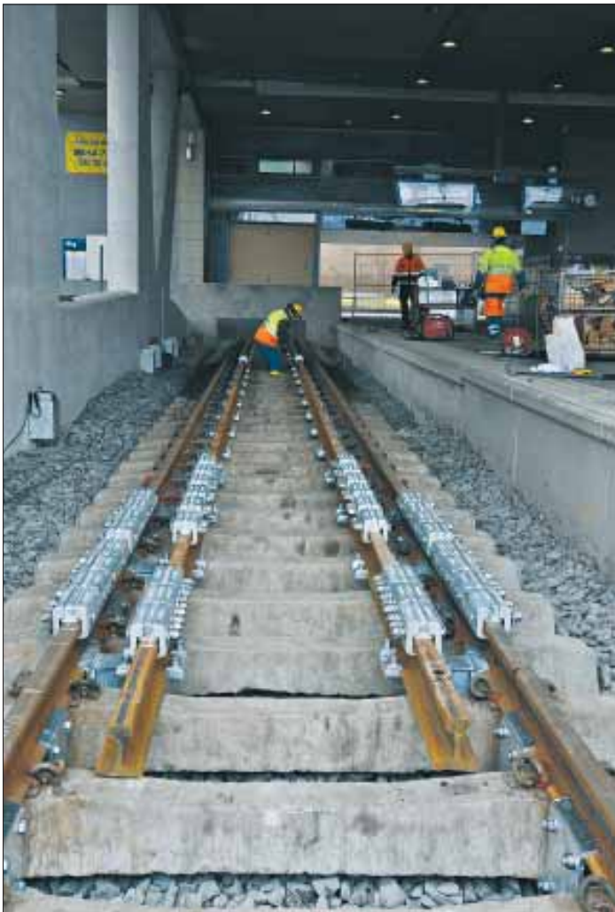
Kuva 2. Raidepuskimen kitkaelementit asennettuna raiteeseen ja apukiskoihin (kuva Tuukka Halttunen).
