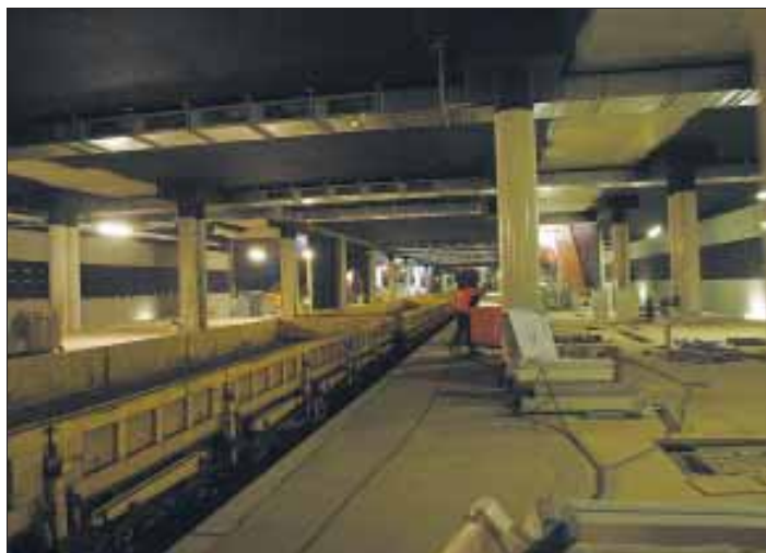
Laituritasot valmistumassa, huomaa betonipilarien marmorimainen pinta.
