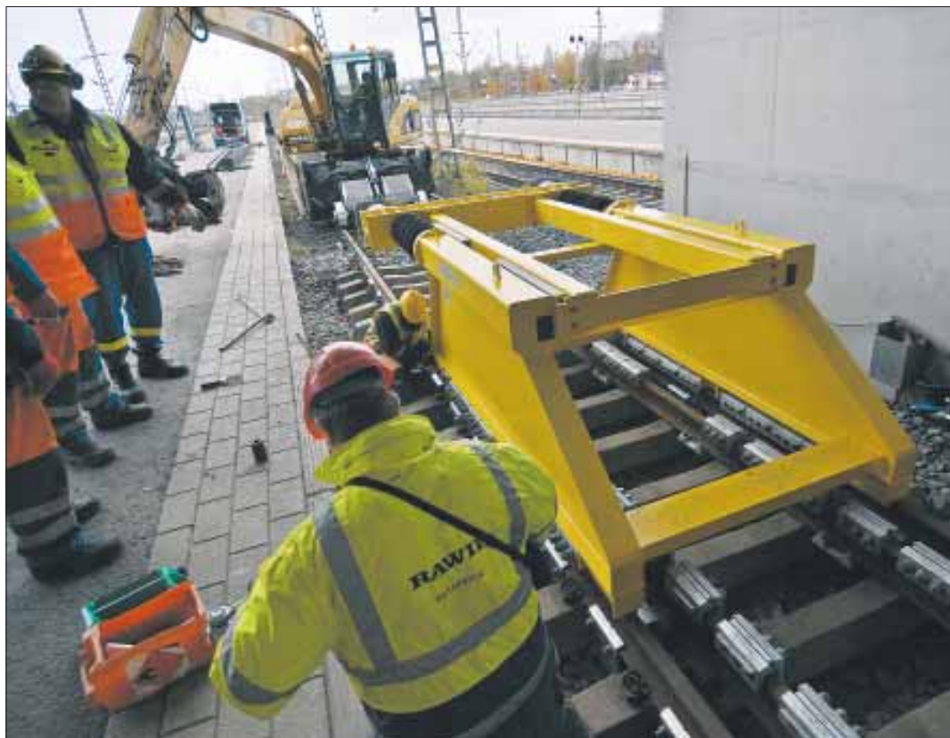
Kuva 1. Raidepuskimen asennus käynnissä Helsingin rautatieasemalla (kuva Tuukka Halttunen).
