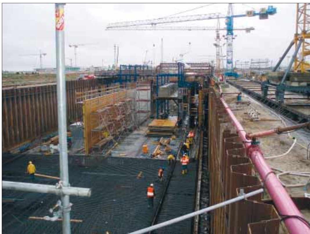
Betonitunnelia rakennetaan tukiseinien sisällä.
