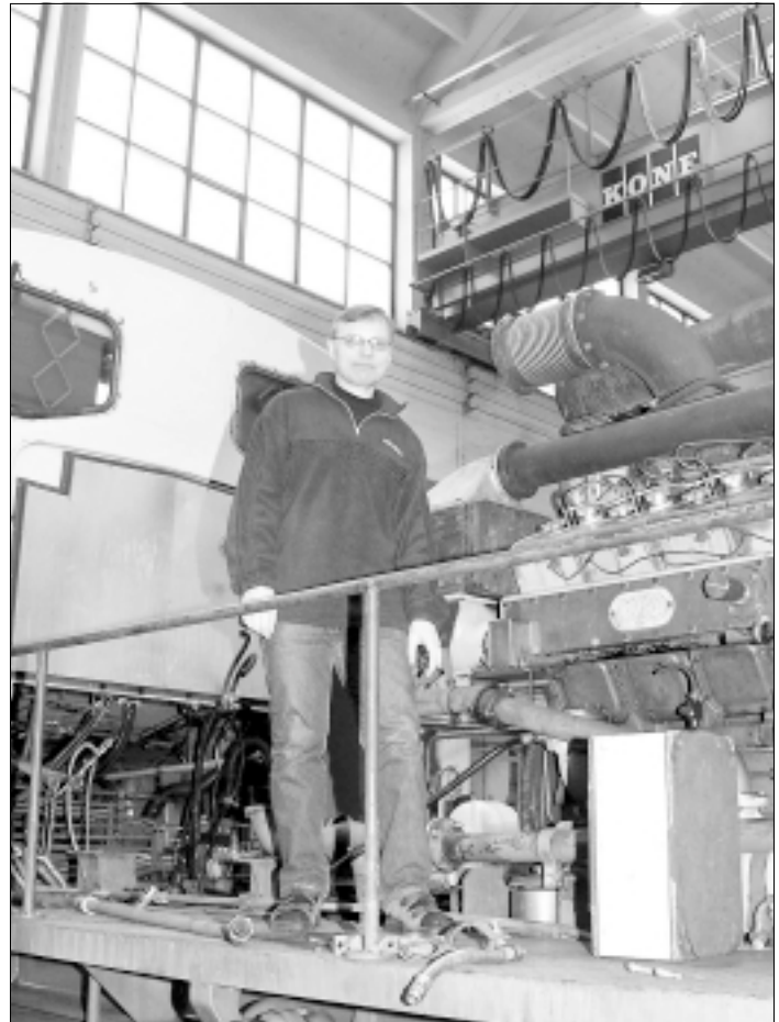
Pienistä alkuvaikeuksista huolimatta Esa Kivikangas on tyytyväinen saneerauksen sujumiseen.
