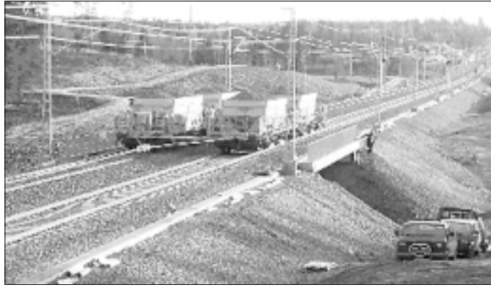
Koekuormitustilanne 30.10.2005, vaunujen paino yhteensä 4 \times 75 \text{ ton} = 300 \text{ ton} . Silta on kaksiraiteinen kolmiaukkoinen laattasilta, jännemitat 8+12+8 \text{ m} , kokonaispituus 34 \text{ m} , hyödyllinen leveys 11.9 \text{ m} .
