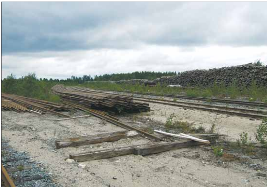
Laajakankaan ratapiha kesällä 2008 ennen rakennustöiden aloittamista.
