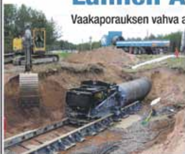
Työntöporaus American Augers 72-1200NG koneella, DN1600 asennus.
