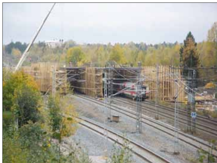
Pääradan päälle tehdään telinettä siltalohkon 4 rakentamista varten.
