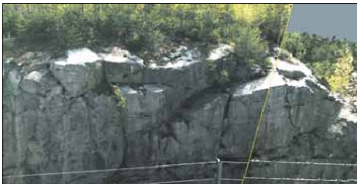
Kuva 4. Laserkeilausaineiston käyttö kallioleikkausten yläreunojen halkeamien tunnistamiseen. Vasemmalla puolella keilauksen yhteydessä otettu valokuva ja oikealla puolella valokuva-aineiston perusteella värjätty pistepilvi.
