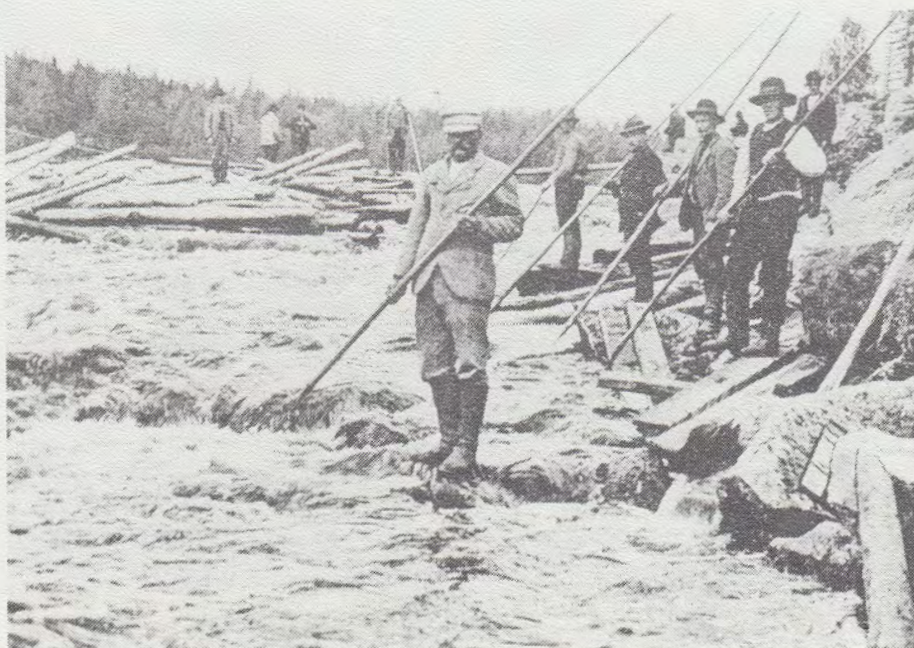
Uittotyö käynnissä Siuronkoskella 1900-luvun alussa. (Kuva saatu toimittaja Vuokko Suuniitulta. Om. sosiaali-päällikkö Jaakko Hälli.)
