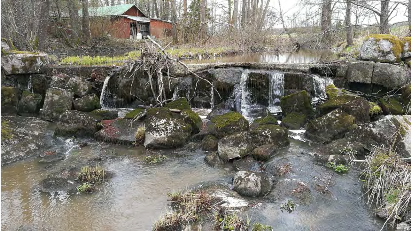
Kuva 20. Åmunsbäckenin alaosassa sijaitseva myllypato estää kalojen vaeltamisen merestä puroon.
