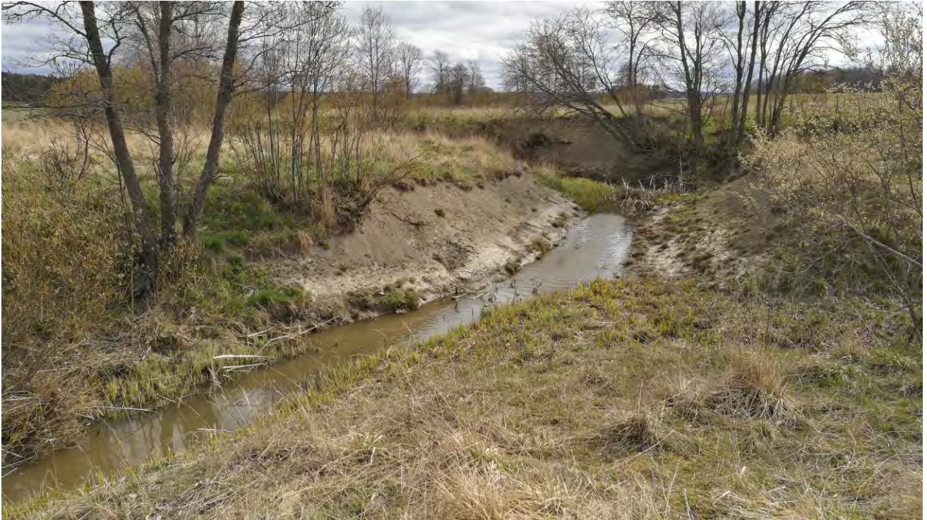
Kuva 17. Torsbölebacken virtaa alaosillaan herkästi sortuvassa maaperässä.
