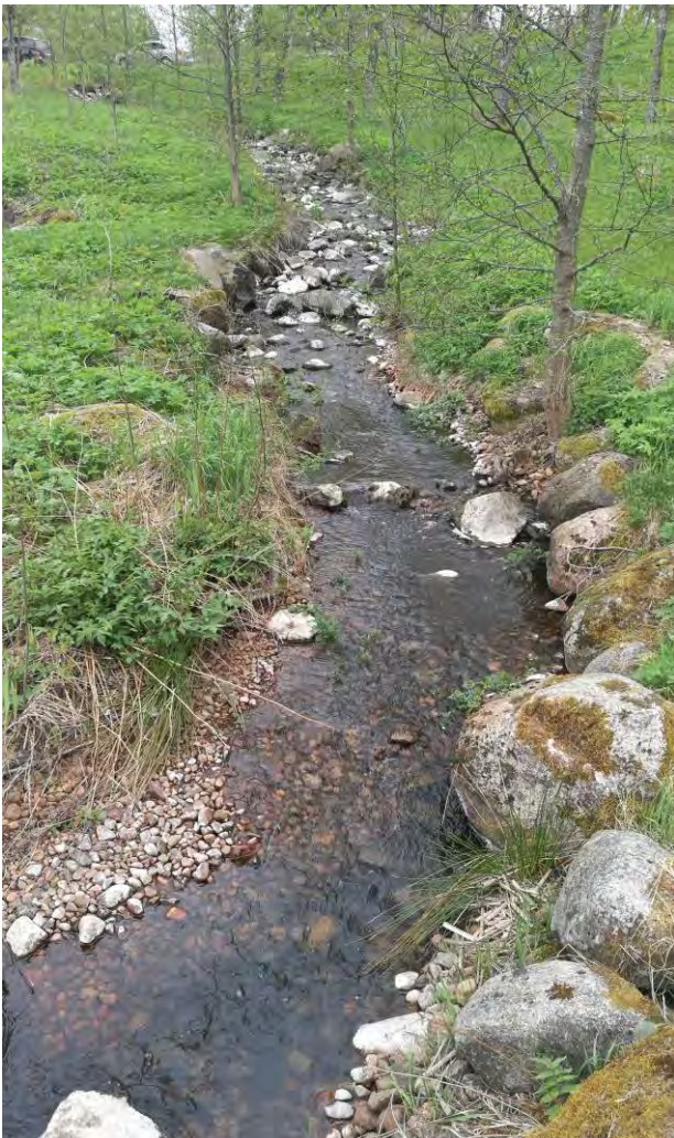
Kuva 55. Björkbodabäckenin rakennettu ohitusuoma on luonnonmukainen koskiuoma.
