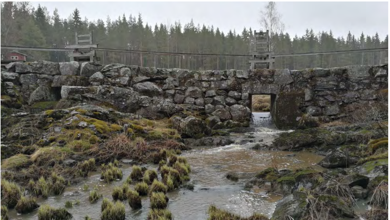
Kuva 26. Kobböleforsenin myllypato todennäköisesti estää kalojen vaeltamisen ylävirtaan
