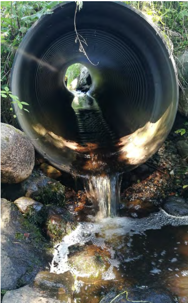
Kuva 29. Hertsbölevikenin puron toiseksi alin tierumpu muodostaa kaloille vaellusesteen.
