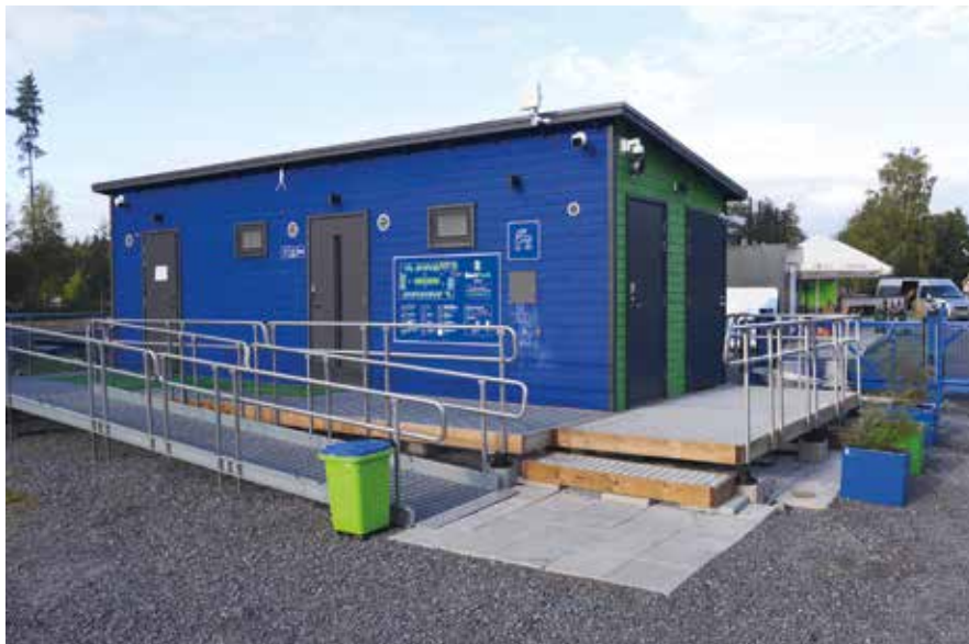
BestPark -konseptiin kuuluu, että kaikki huoltotoimet on sijoitettu kompaktiin huoltorakennukseen.
