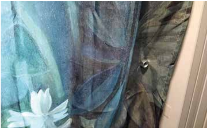
Mutteri-magneetti -yhdistelmät pitävät suihkuverhon kiinni seinässä suihkun aikana.
