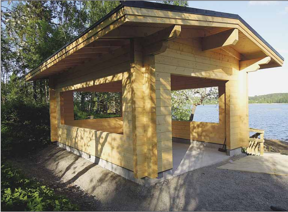
Grillikatot valmis, takana monta vaihetta ja paljon työtä
