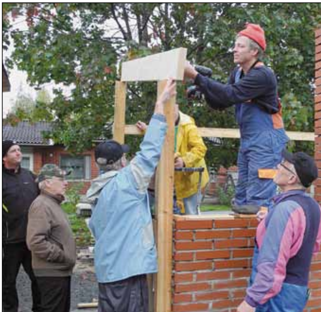
Toimintakeskuksen johtaja lion Risto Hoikkanen asentaa kesäkeittiön katonkannatinta.
