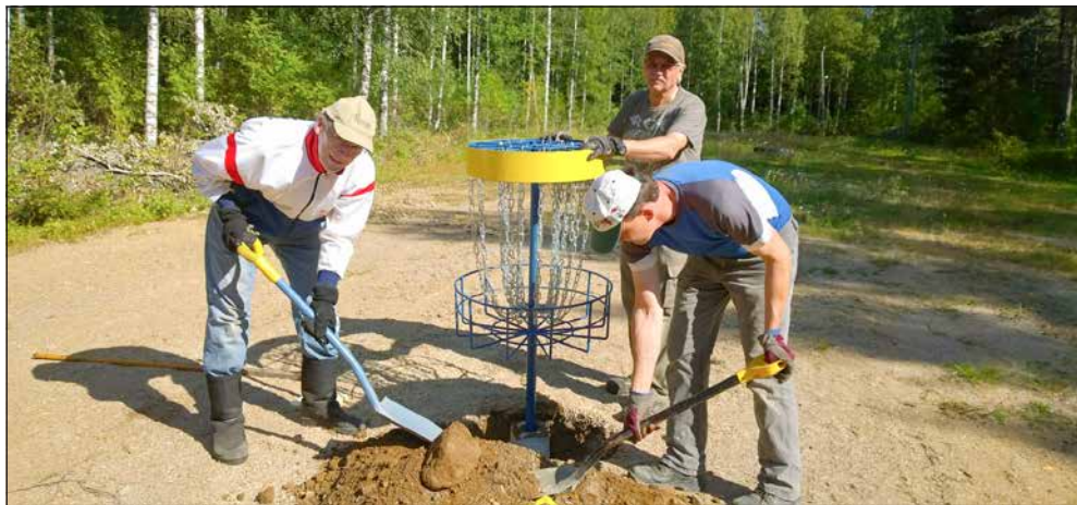
Leijonaveljet työn touhussa – frisbeerataa rakentamassa lapion varressa vasemmalta Otti Linnikko ja Jari Mäkelä. Keskellä asettaa koria paikalleen hankkeen vastuuleijona Esa Piippo.
