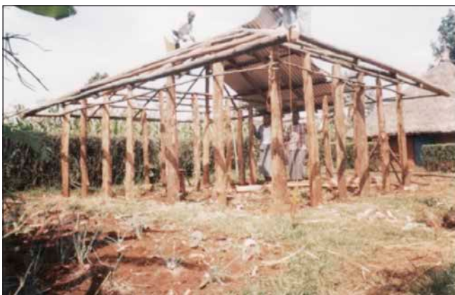
Uusi koti rakenteilla Kisumussa 2011
