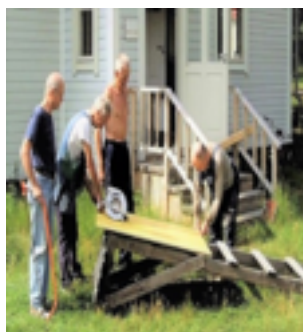
Kuva 2: Levyn mitoitus ja leikkaus käynnissä
