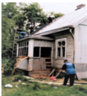
Kuva 1: Kuistin ja katon saneeraus
