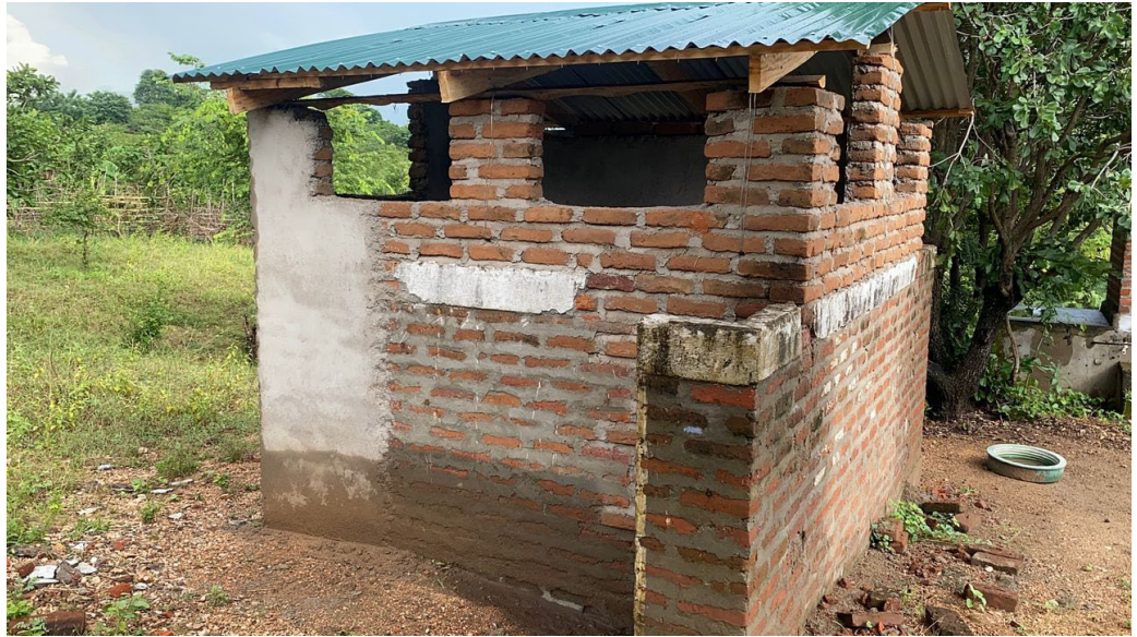
Tyttöjen saniteettitila valmistumassa.
