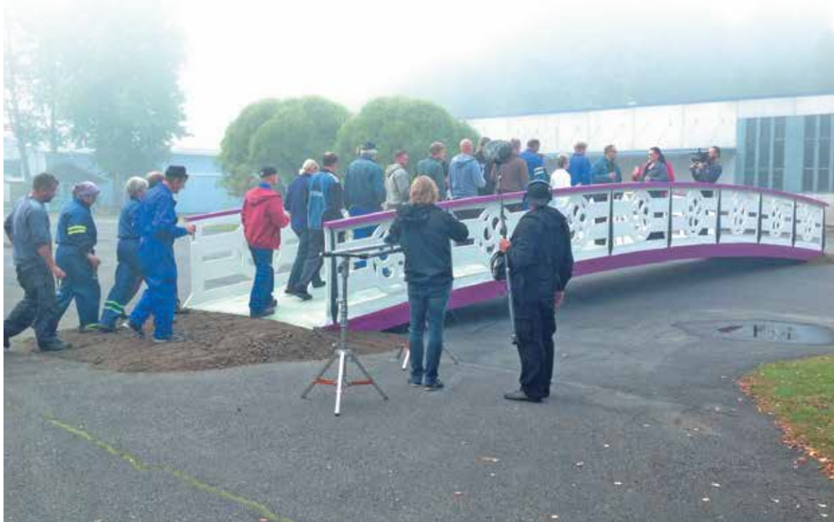
Virtasalmella sijaitseva muovialan yritys Ekin muovi on valmistanut prototyypin sillaksi kyseiseen tarkoitukseen. Tämä 15 metriä pitkä ja 2,5 metriä leveä 3200 kg painava silta on kantavuudeltaan 25000 kg. Sillan voi myös pinnoittaa esim. asfaltilla, soralla tai kumipinnoitteella. Suhteellisen kevyen rakenteensa vuoksi sillan siirtäminen tehtaalta suunniteltuun paikkaan onnistuu vaivattomasti rekka-kuljetuksella.
