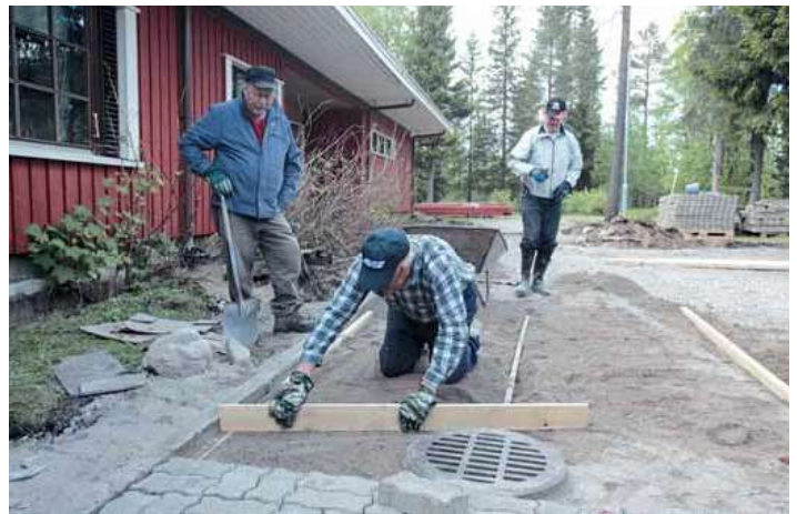
Tiukan pohjahiekan päälle huolellisen tasoittamisen jälkeen ladotaan kuviolliseksi valetut laatat paikoilleen tarkan suunnitelman mukaisesti.
