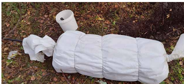
"Vesipesä" on iso teräsverkkorulla. Vesiputken lähtöpää on ankkuroitu rullan sisälle. Suodatinkangas on kiinnitetty huolellisesti verkon päälle rautalangalla. Vesipesä mäyttää isolta karamellipaperilta.
