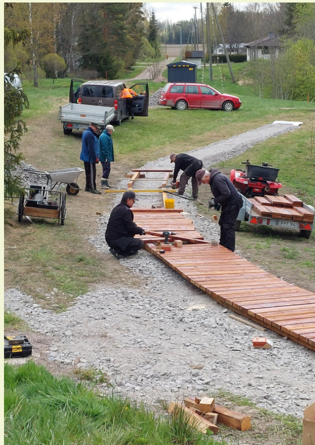
Lankkupolun asennus käynnissä.
