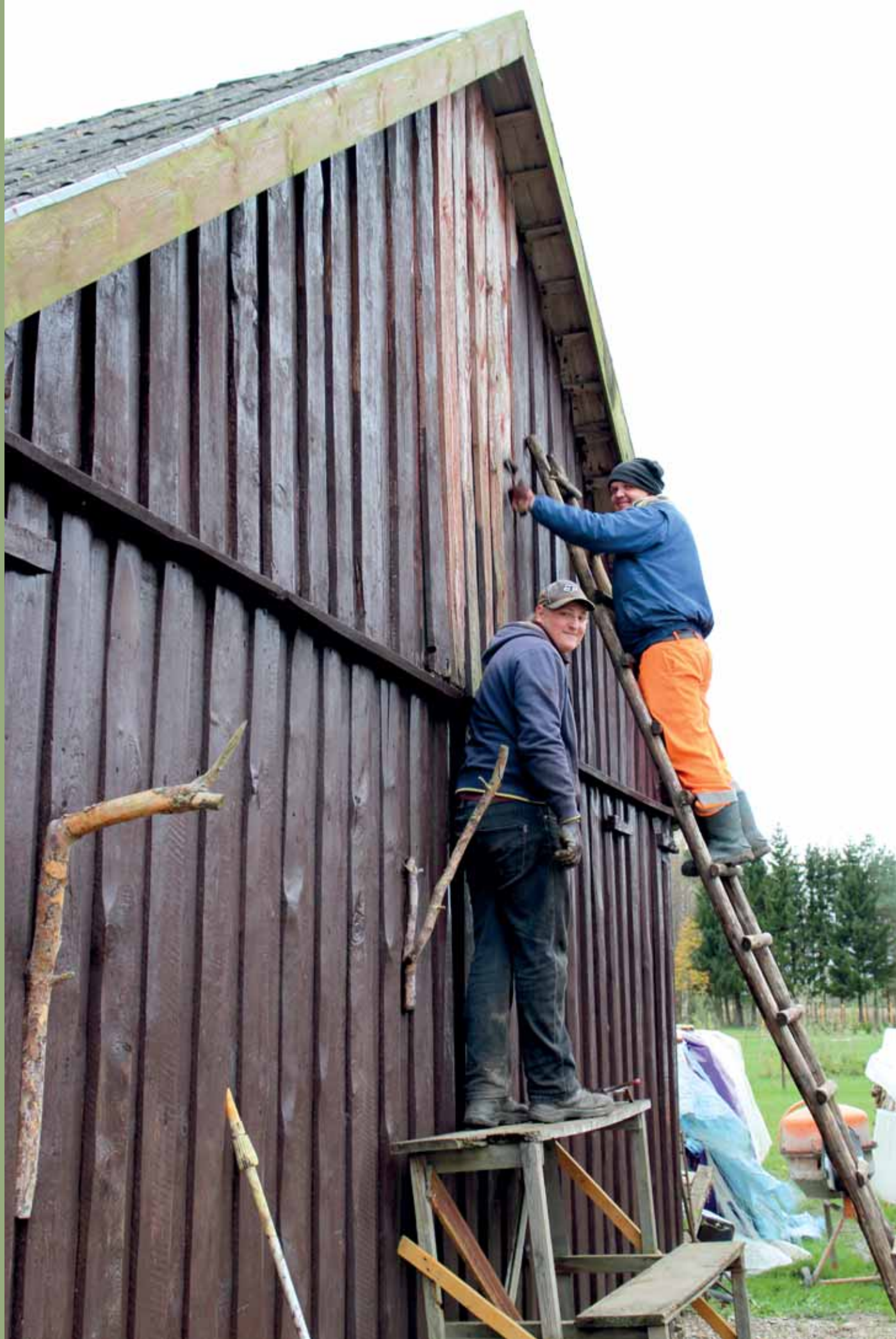
Miespuoliset asiakkaat maalaamassa eläinsuojan pätyä.
