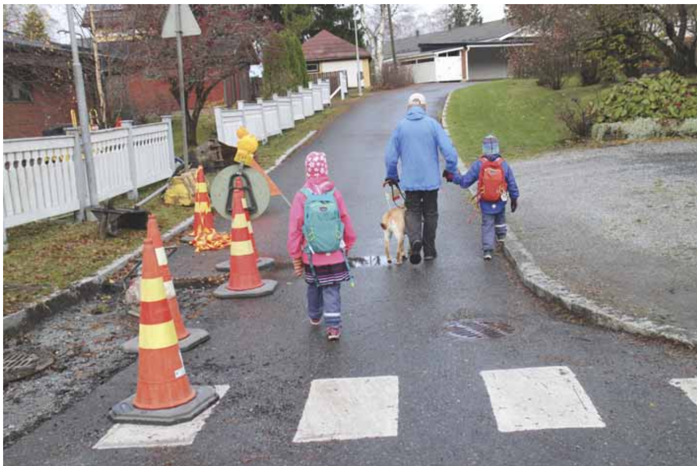
Alina ja Arttu Silas kävelevät kouluun hyvässä seurassa. Isä Jannen ja opaskoira Hugon kanssa matka sujuu turvallisesti. Tietyömaa erilaisine härveleineen ei hämännyt Hugoa, vaikka se oli vastikään aloittanut oppaan hommat. Kuva: Juha Herttuainen
