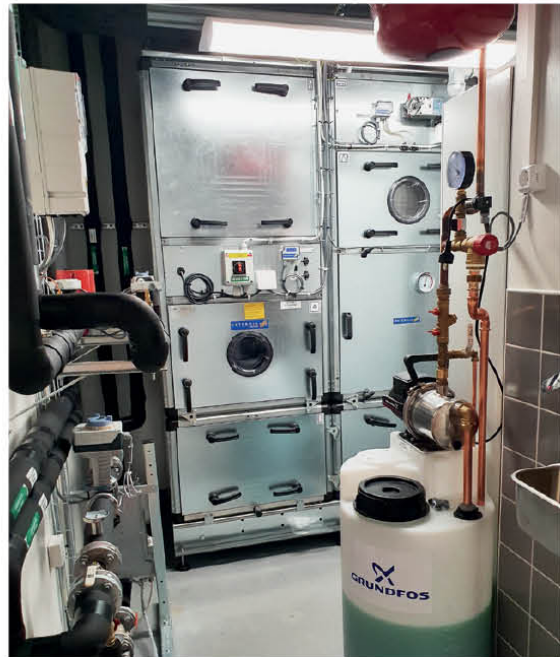
Uuden lastenosaston RETCARE IN S tuloilmakone, jossa raitis- ja tuloilman kanavalähdöt ovat koneen päällä.
