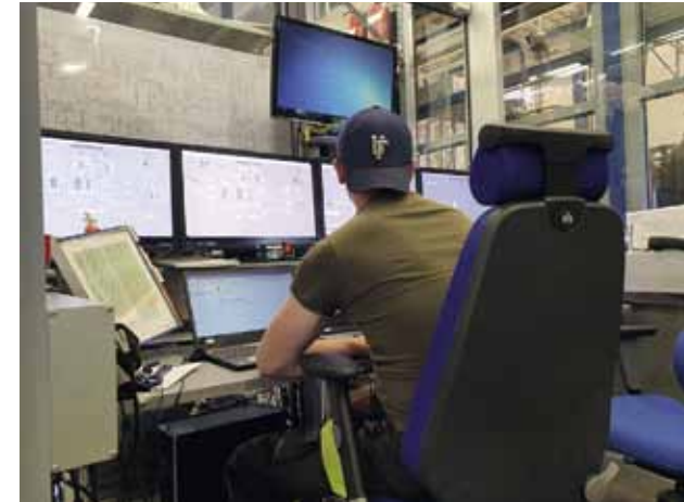
Woikosken kaukovalvontajärjestelmä valvoo asiakaskohtaisesti säiliöiden pintalukemia ja kaasukeskusten paineita.
