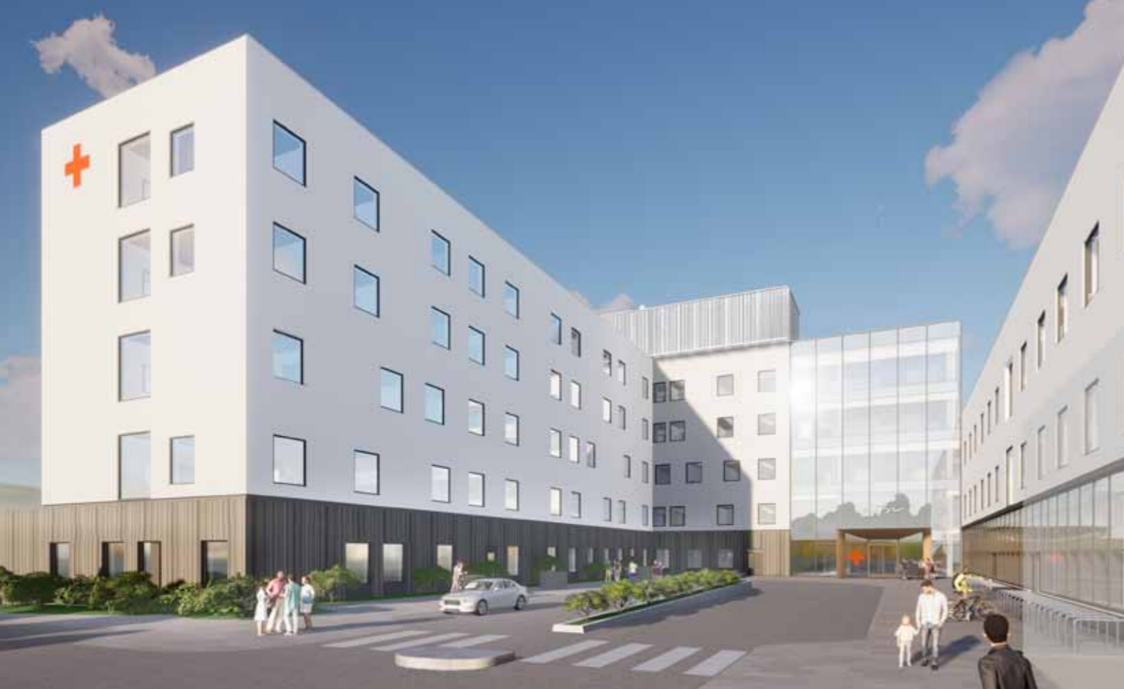
Ahveniston Assi-sairaalan rakennustyöt käynnistyivät elokuussa 2021. Vuonna 2026 käyttöön otettavan sairaalan pääsisäänkäynti näyttää tältä.
