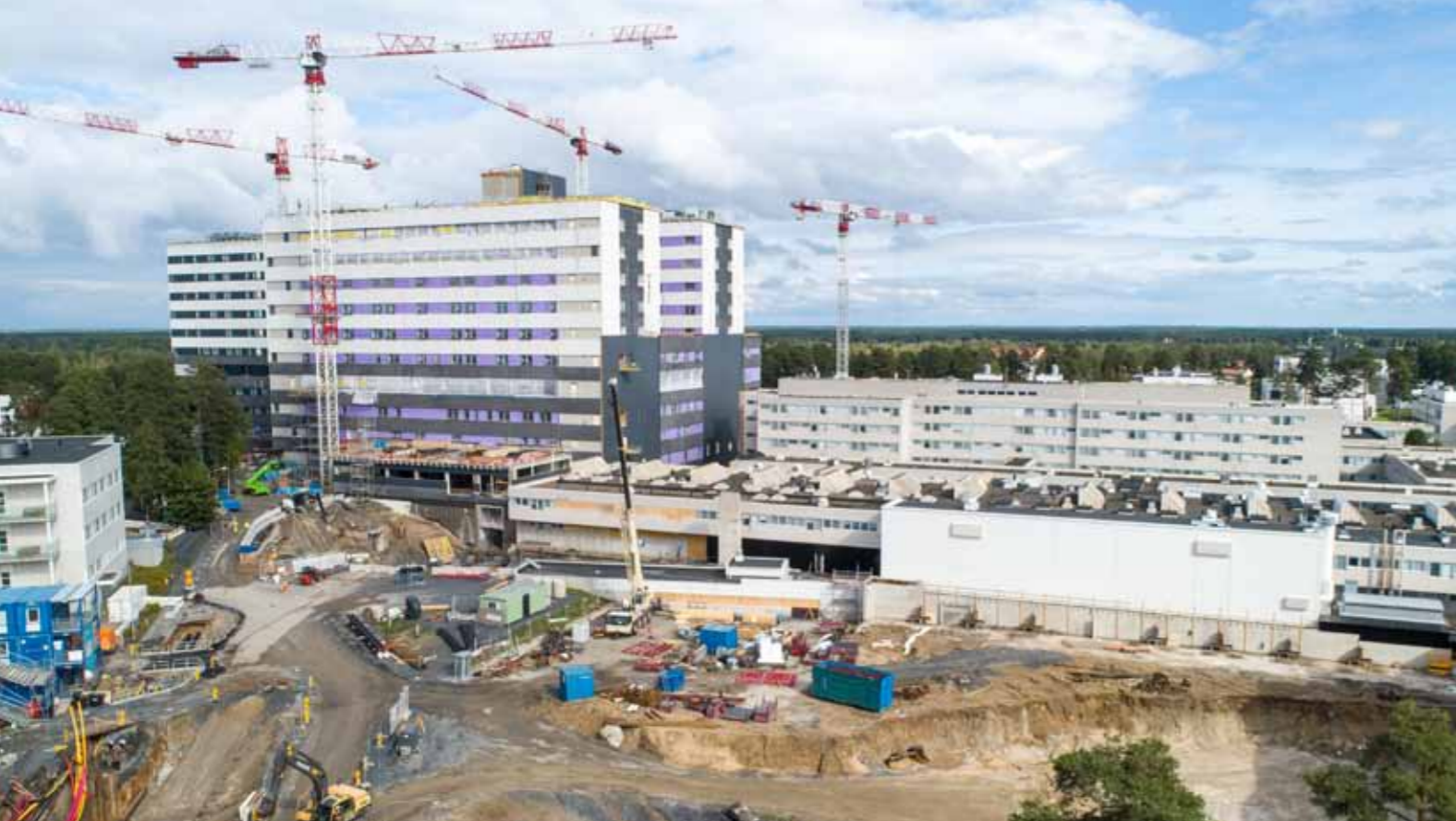
Oulun yliopistollisen sairaalan rakennustyömaa on yksi Suomen suurimmista.
