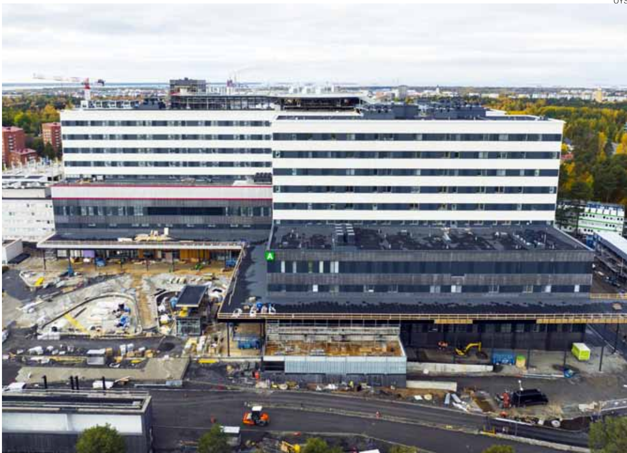
SSTY:n turvallisuusjaostossa turvallisuus- ja varautumisasioita käsitellään laajasti. Uusien sairaaloiden turvallisuus on yksi viime vuosien kestoaiheita. Kuvassa Oulun yliopistollisen sairaalan rakennustyömaata.
