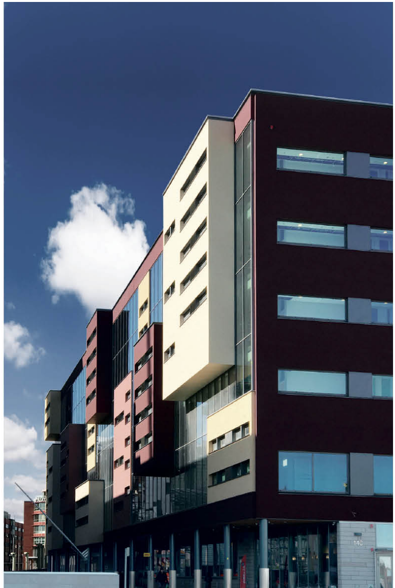
Helsingin Kalasataman terveys- ja hyvinvointikeskus viitoittaa tietä terveydenhuollon tulevaisuuden rakentamiselle.
