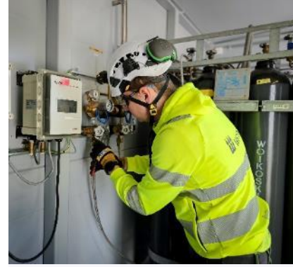
Kaasuverkoston huolto ja kunnossapito
