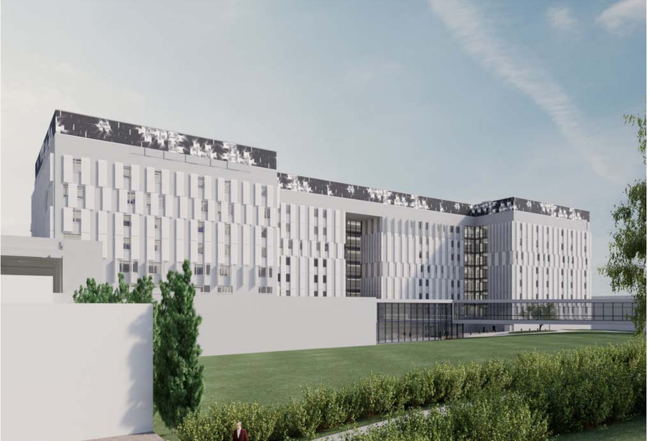
Pohjois-Savon hyvinvointialueella on käynnissä KYS Uusi Sydän -projekti, jossa rakennetaan muun muassa uusi sairaalatorni.
