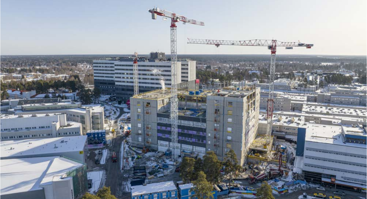
Oulun uuden yliopistosairaalan rakennustyöt ovat käynnissä. Työmaan tilanne näytti tältä maaliskuussa 2023.
