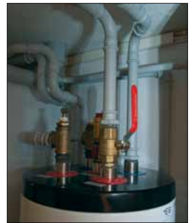
Ilma-vesilämpöpumppu asennettiin päivässä. Sitä ennen piti vain sulkea ja poistaa vanha paisuntasäiliö vintiltä, jotta patterikierrossa pysyy nyt oikea paine.
