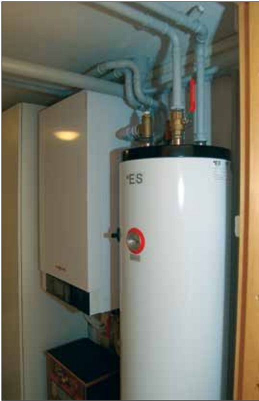
Ilma-vesilämpöpumppu asennettiin päivässä. Sitä ennen piti vain sulkea ja poistaa vanha paisuntasäiliö vintiltä, jotta patterikierrossa pysyy nyt oikea paine.
