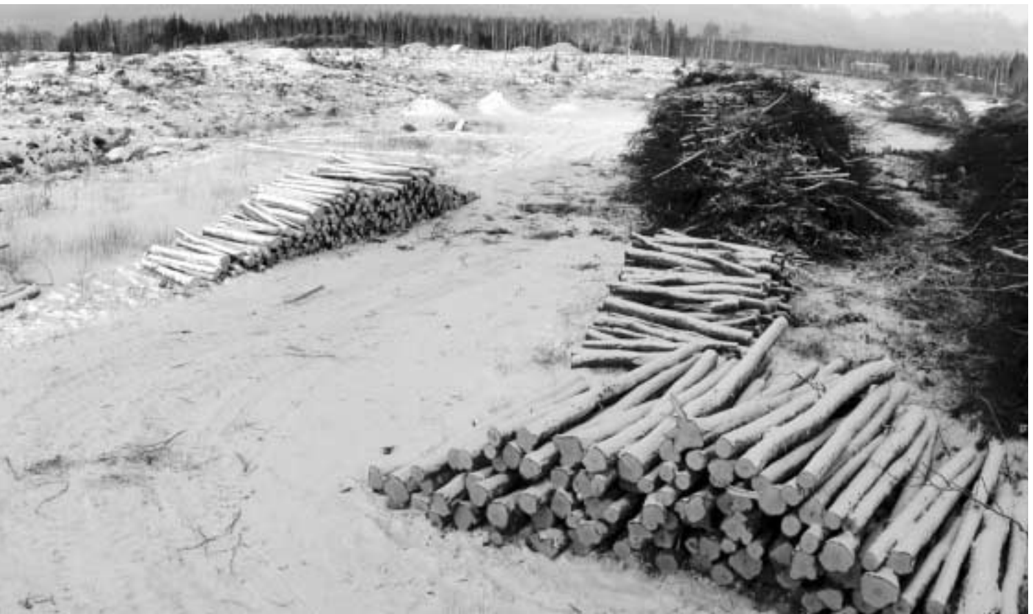
Hakkuutyöt tulevan ydinvoimalaitoksen alta on jo aloitettu. Kuva: Hannu Huovila, TVO.
