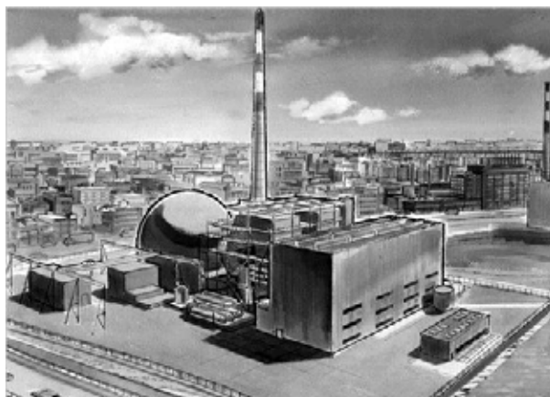
Consolidated Edison haki tammi-kuussa 1962 Atomic Energy Commissionilta lupaa 1000 MW:n ydinvoimalaitoksen rakentamiseksi East Riverin varrelle New York Cityn Queensiin. Sijaintipaikan liikenneyhteydet ovat erinomaiset, lähelle tulee mm. maanalainen. Laitosta ei koskaan rakennettu, koska ConEd peruutti hakemuksensa talvella 1964 – todeten kuitenkin, ettei paikallisella vastustuksella ollut mitään tekemistä päätöksen kanssa. Kuvat: ConEd ja New York Times.
