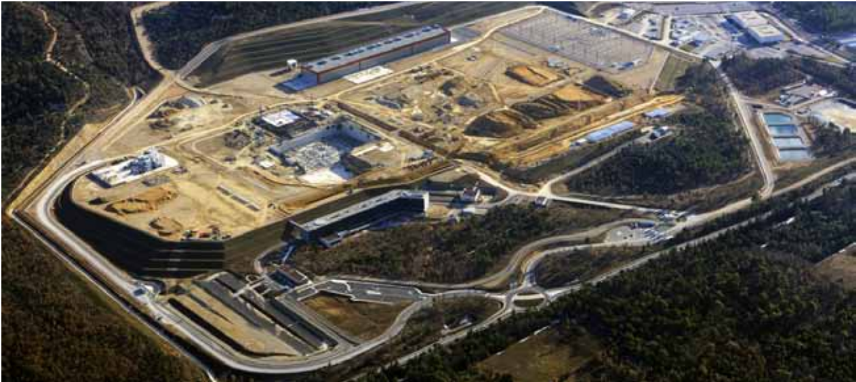
ITER reaktorirakennuksen työmaa 2013. Kuva: ITER.
