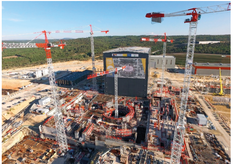
ITERin työmaa Ranskan Cadarachessa lokakuussa 2017. Rakennuksia nousee kovaa vauhtia pystyyn ja varsinaisen reaktorirakennuksen ympärinmuotoinen aihio näkyy kuvan keskellä (kuva: ITER Organization).
