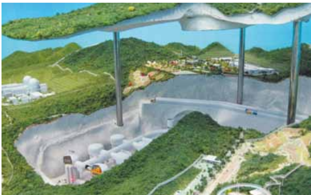
Korealaiset osaavat rakentaa ja osaavat myös esitellä osaamistaan. Hyvällä englannin kielellä pidetty esittely ja ydinvoimalaitosalueen pienoismalli antoivat selkeän kuvan alueesta ja sen toiminnasta.
