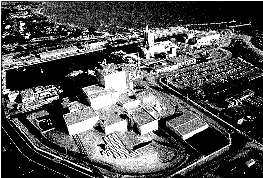
Uraanirikaste muunnetaan puhtaaksi uraaniheksafluoridiksi ( UF_6 ) konversiolaitoksessa. Kuvassa on Port Hopessa Kanadassa sijaitseva konversiolaitos, jonka vuosikapasiteetti on 10500 tonnia uraania.
