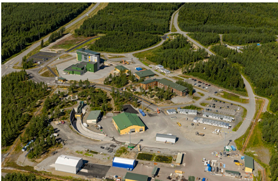
Ilmakuva vuodelta 2015 Posivan käytetyn ydinpolttoaineen loppusijoituslaitospaikasta Olkiluodossa.
