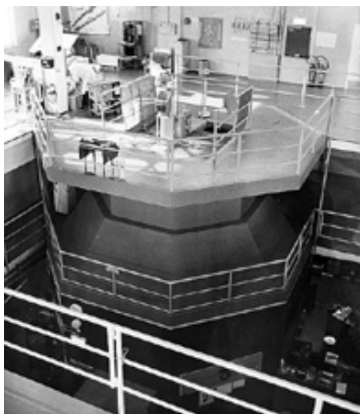
Vy uppifrån av FIR 1 år 1966 med reaktortank och betongskydd.
