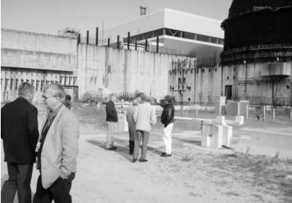
Kuvassa ATS-ryhmä tutustumassa keskenjääneen yksikön rakenteisiin. Taustalla turbiinisali, joka toimii toimivan laitoksen varasto- ja aputilana. Etualalla valvomon seinärakenteita.
