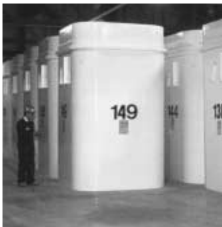
Käytetyn polttoaineen kuivavarasto.
