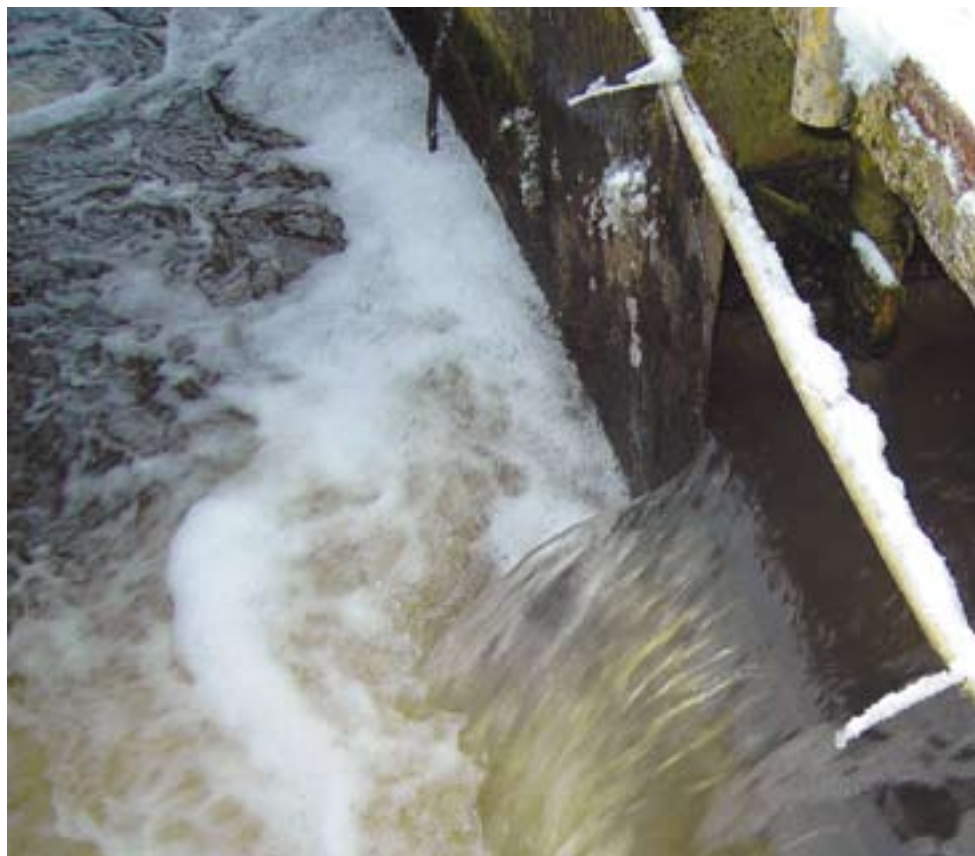
Teollisuuden jätevedet virtaavat usein avokanavissa, missä myös niiden virtausmittaus toteutetaan. Mittalaitteina käytetään mm. mittapatoja.
