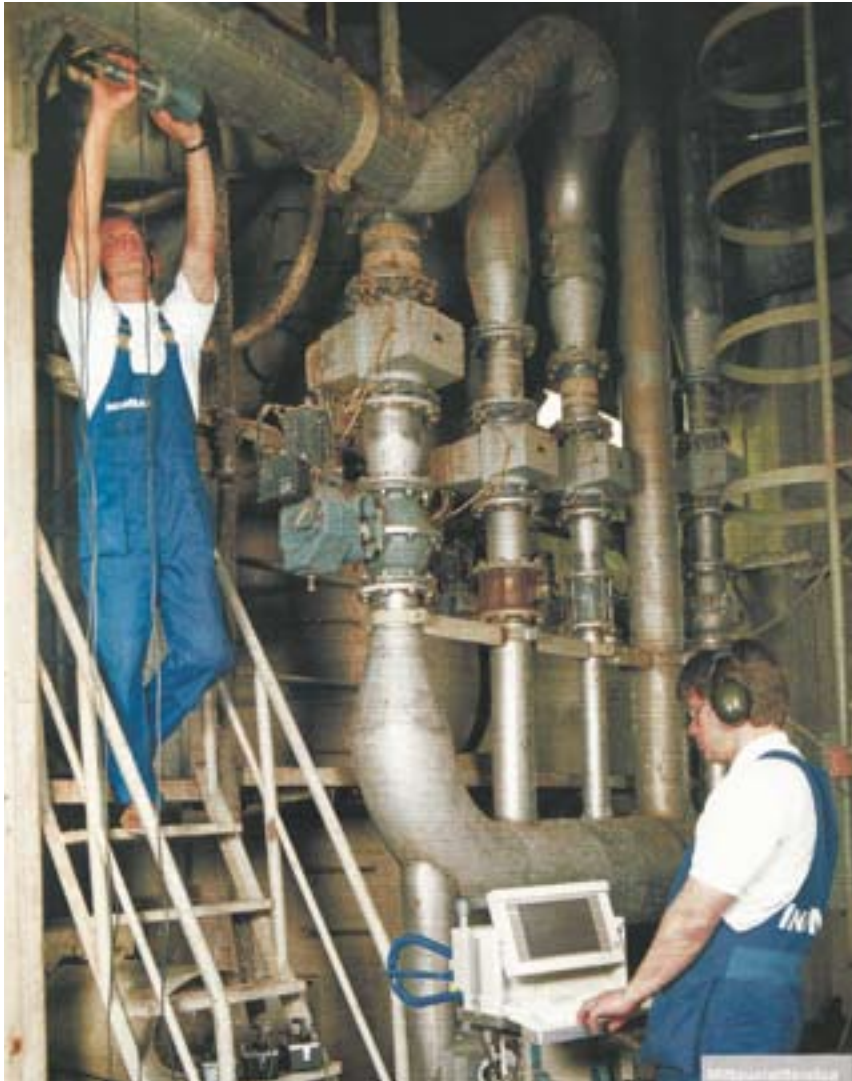
Mittauslaitteistoa asennetaan virtausmittauksen kalibrointia varten.
