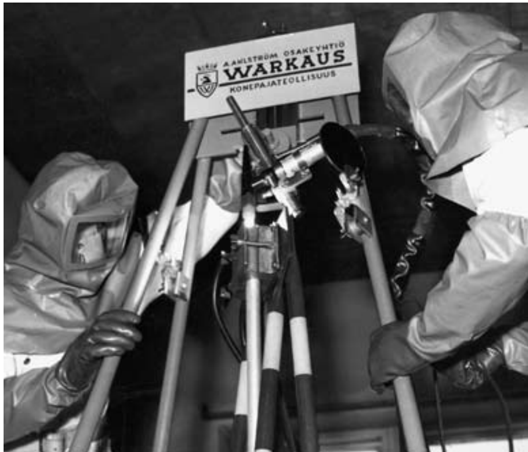
Espoon Otaniemeen valmistetun alikriittisen miilun polttoaine-elementin hitsausta A. Ahlström Osakeyhtiössä Varkaudessa vuonna 1958.
