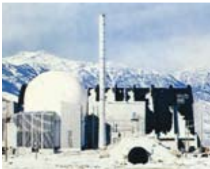
1970-luvulla osallistuttiin moniin pitkiin kokeellisiin tutkimuksiin. LOFT -kooreaktori Idahan erämaassa USA:ssa simuloi painevesireaktorin primääripiiriä suhteessa 1:60
