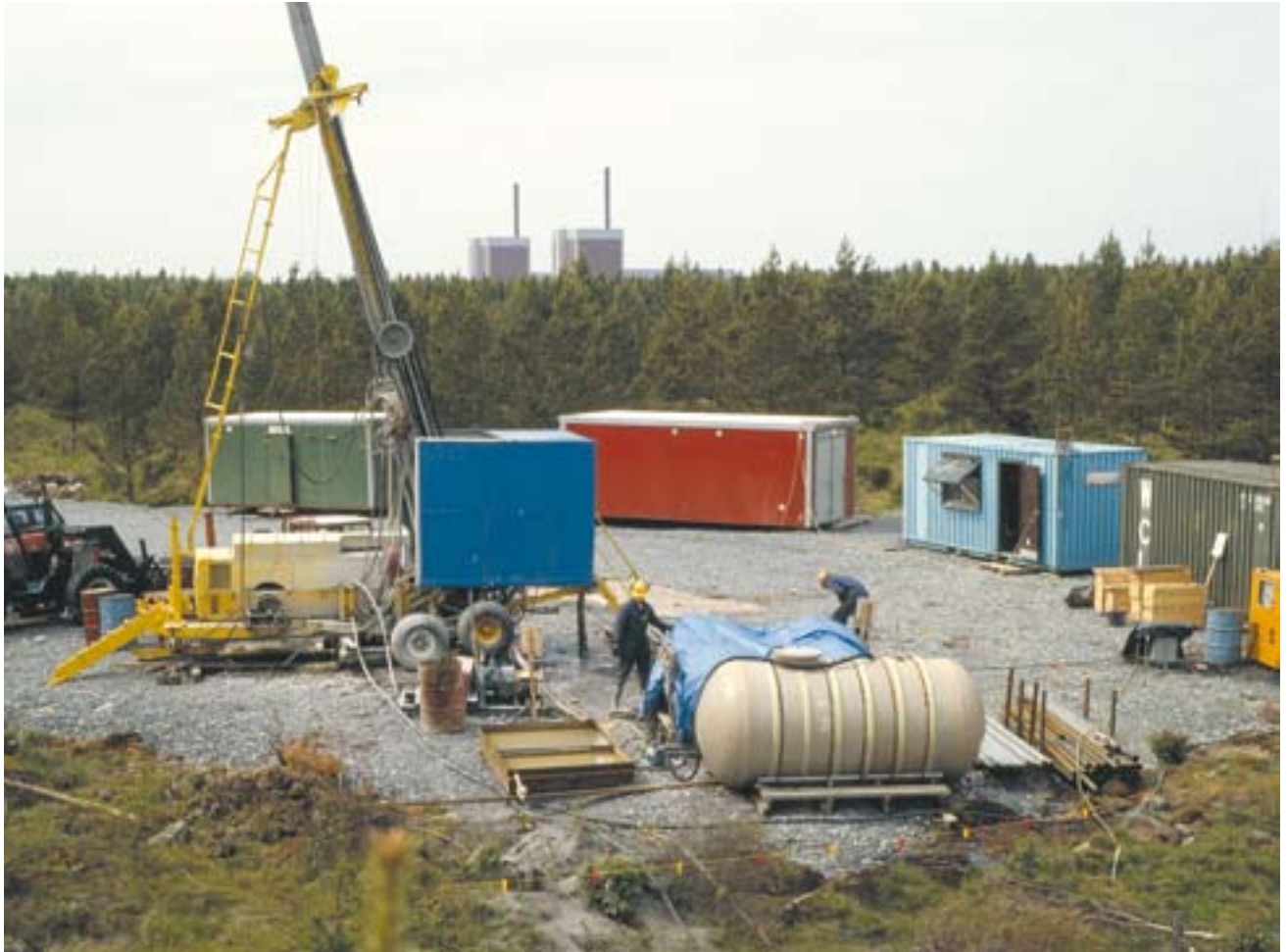
Tutkimuslaitteistoa Olkiluodossa: KR1:n poraus vuonna 1989.
