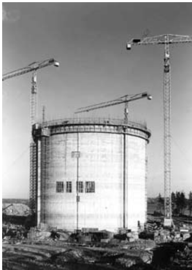
Loviisan ykkösreaktorin ulomman, teräsbetonisen suojarakennuksen rakentamisen tilanne lokakuussa 1971. (Kuva: Fortum Power and Heat Oy.)
