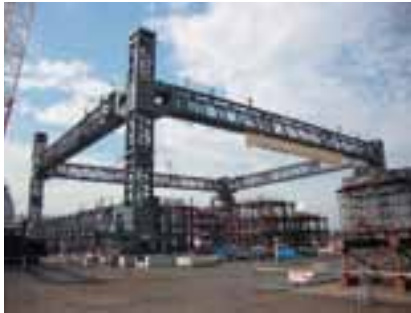
Kuva 4. Fukushima Dai-ichin ykkösyksikön sääsuojan tukirakenteita koeasennettuna ONahaman satamassa 24.6.2011. Kuva: Tepco
