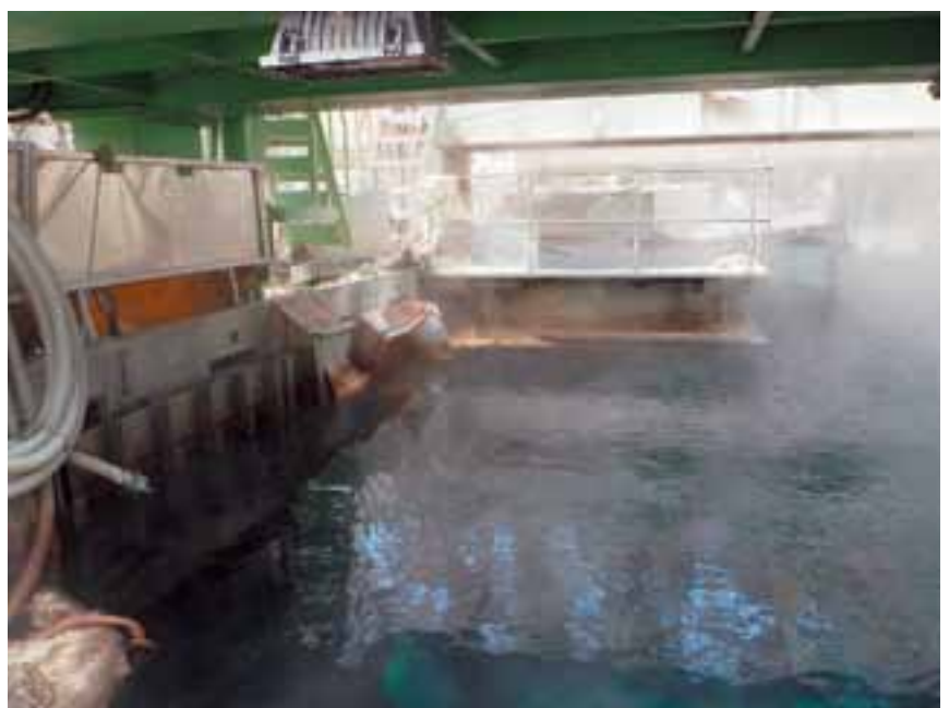
Kuva 5. Fukushima Dai-ichin nelösyksikön polttoaineallas on viimeisenä ilman jäädytyskiertoa räjähdysen vaurioitettua putkistoa. Kuva: Tepco 29.6.2011
