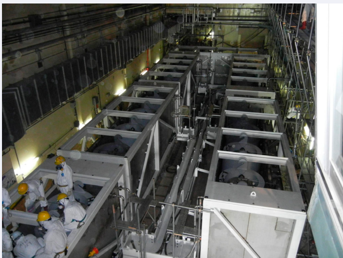
Kuva 1. Fukushimassa radioaktiivisista jätevesistä puhdistetaan cesiumia CsTreat-ioninvaihtimilla ALPS-järjestelmän absorptiotorneissa.
