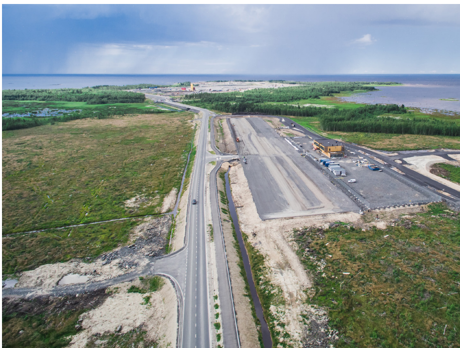
Etualalla koulutusrakennus ja taka-alalla työmaa Hanhikiven niemen kärjessä.
