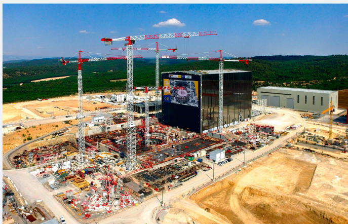
Kuva 1. Rakentaminen alkoi 2010 Cadarachessa Ranskassa ja se edennyt jo reaktorirakennukseen. Kuvassa työmaan tilanne heinäkuussa 2016 [1; EJF Riche].
