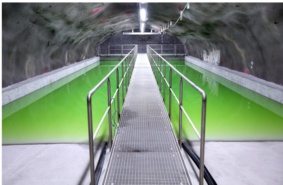
ONKALOn selkeytyksellä erottaa kiintoaineet vedestä ennen veden pumppausta ylös maan pinnalle. Noin 450 metrin syvyydessä sijaitsevaan selkeytysaltaaseen valuu vettä tunnelista ja vedessä oleva kivi- ja maa-aines painuu altaan pohjalle. Veden vihreä väri johtuu merkkiaineesta.
