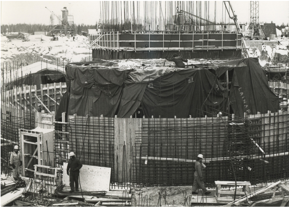
OL1:n suojarakennus muotoutuu. (Kuva: TVO)
