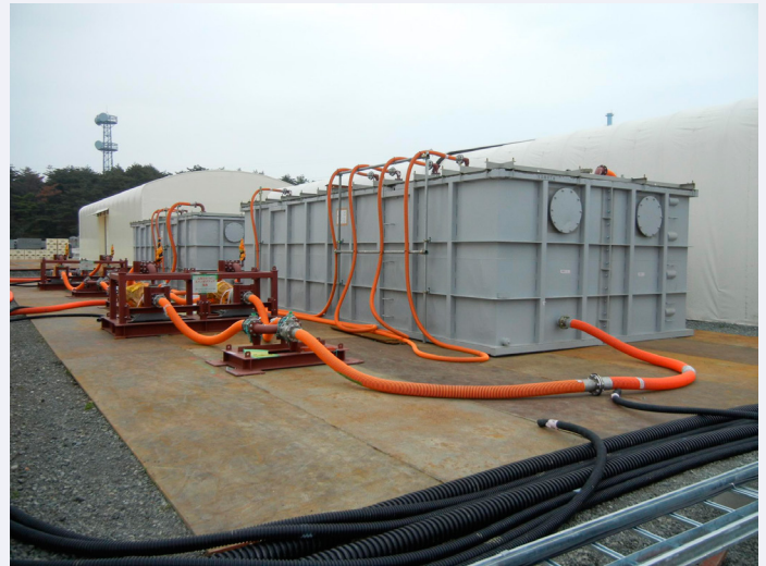
Kuva 3. ALPS-järjestelmällä ja NURES-tuotteilla on heinäkuun 2016 loppuun mennessä käsitelty Fukushimassa noin 560 000 m 3 vettä. Yhteen tällaiseen tankkiin mahtuu 1 000 m 3 vettä
