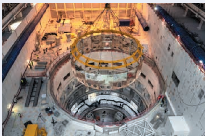
Kuva 1. Lämpösuojan 50 tonnia painava alaosa matkalla loppusijoituspaikkaansa matkustusnopeudella 2 m/min (kuva: ITER).
