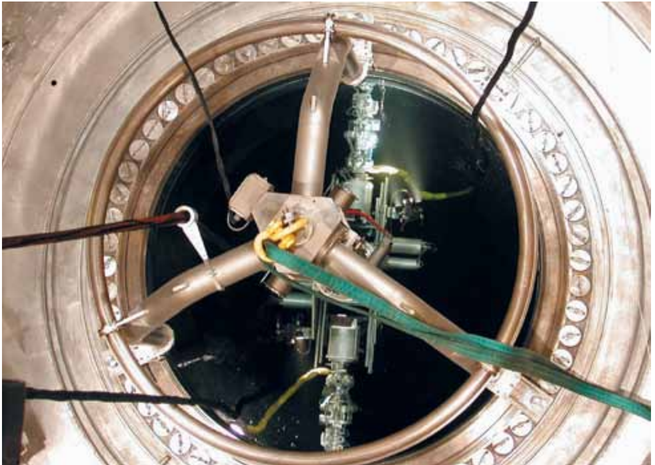
Painesäiliön sisäpuolista NDT-tarkastusta.
